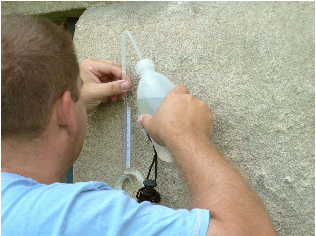
Arbeitsbeispiel: Messung der kapillaren Wasseraufnahmefähigkeit von Natursteinquadern an der Alten Pinakothek München (Foto: Christian Gruber)
