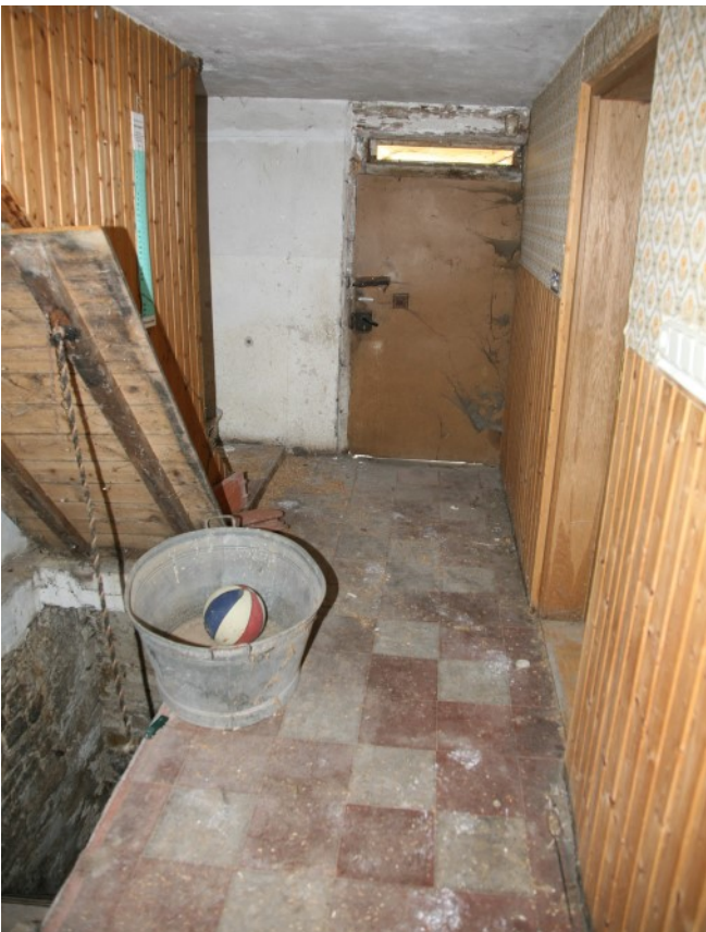
© (E. Knoll) Zugang zum Keller vom Flur
