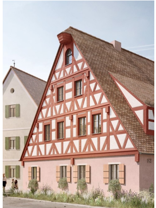
© (I. A.) Eindrucksvoll sanierte Giebelfassade
