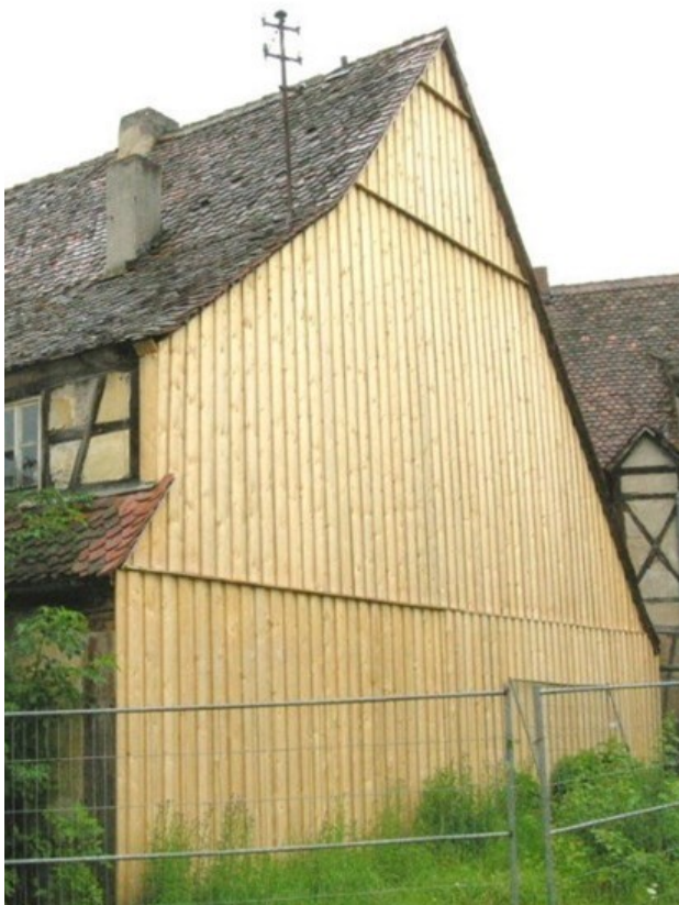
© (E. d. A.) Derzeit verbretterte Gebäuderückseite
