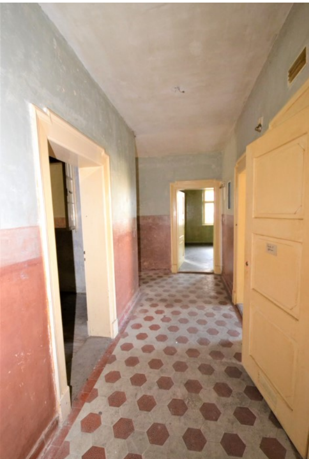
© (G. Gronauer) Flurbereich mit historischem Bodenbelag
