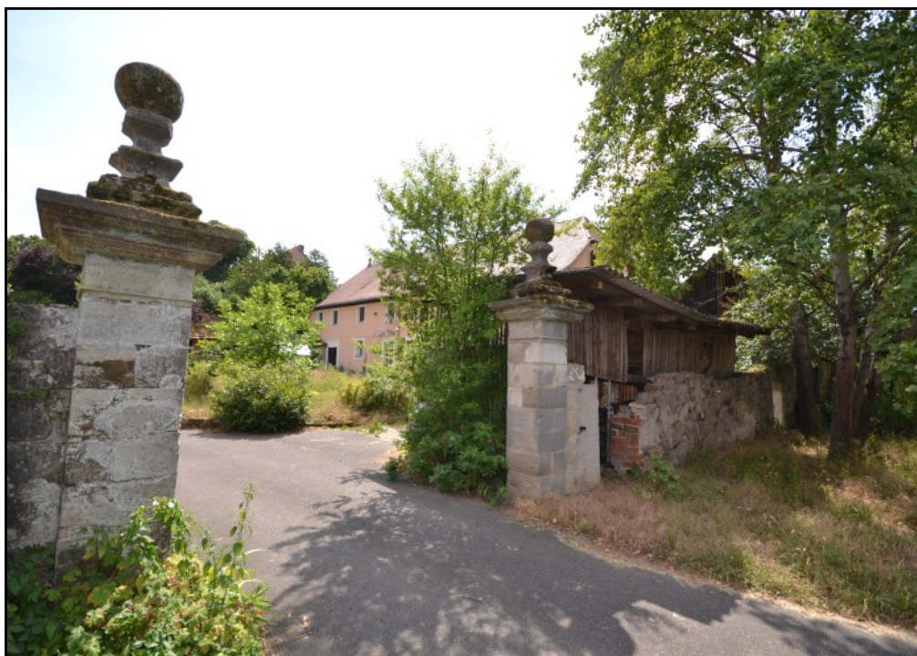
© (G. Gronauer) Zufahrt zum ehemaligen Gutshof
