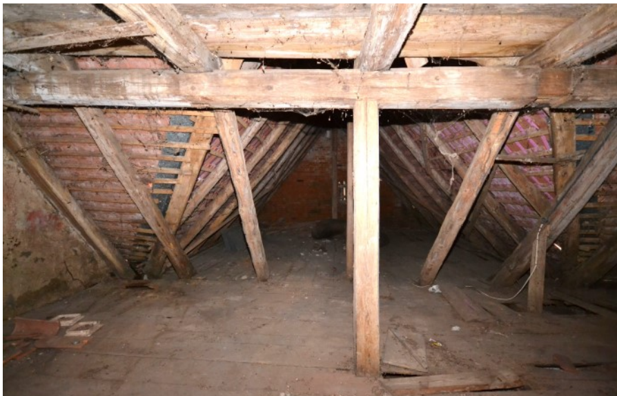
© (G. Gronauer) Historischer Dachbereich
