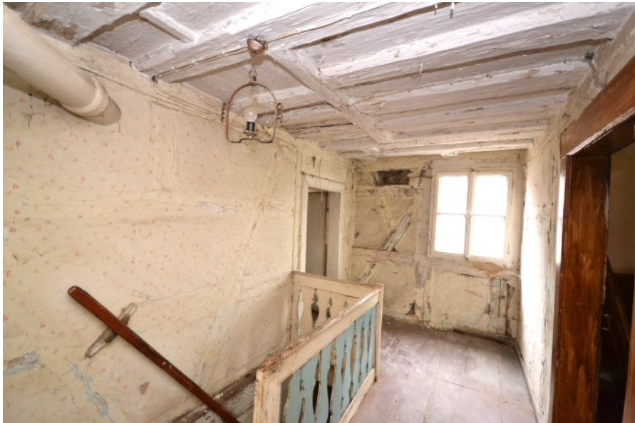
© (G. Gronauer) Balustertreppe ins OG
