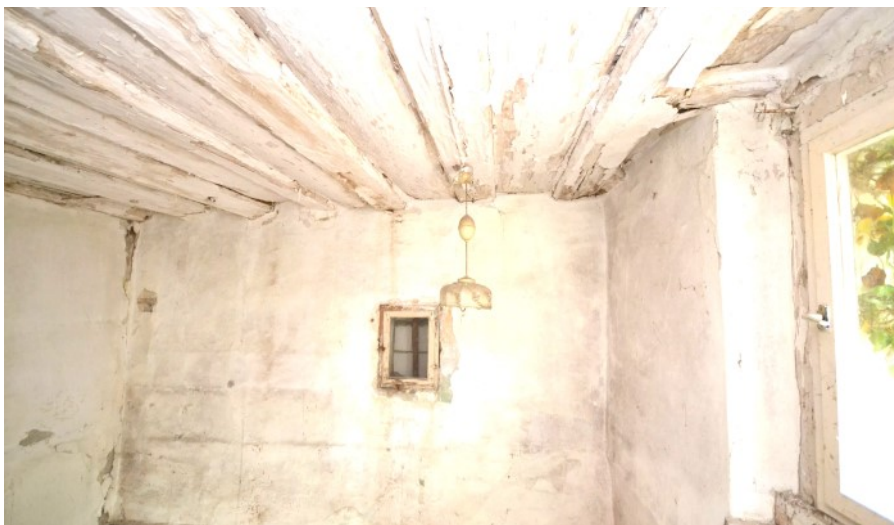
© (G. Gronauer) Verputzte Bohlenbalkendecke
