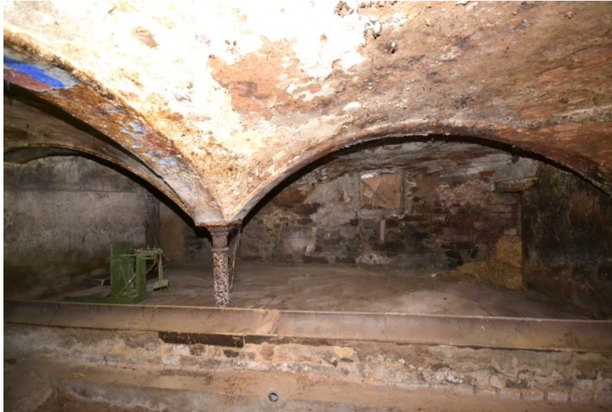
© (G. Gronauer) Ehemaliger Stallbereich mit Gewölbedecke
