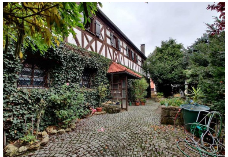
© (A. Suffa) Ehemaliges Wohnstallhaus mit Fachwerkobergeschoss
