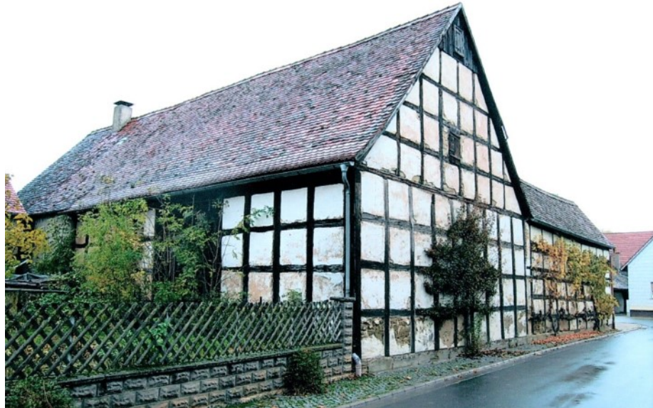
© (EdA) Südostansicht der Hofanlage
