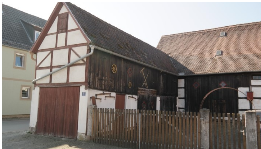
© (BLfD) Fachwerk-Garage mit anschließendem Holzlager
