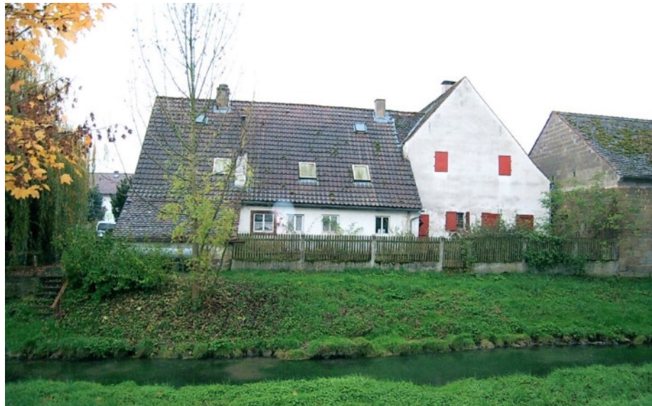
© (EdA) Nordansicht des Bauernhofes nahe der Ehe
