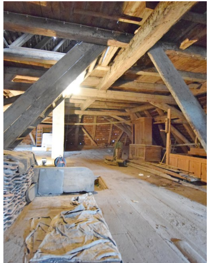
© (Ch. Heitzer) Historischer Dachbereich
