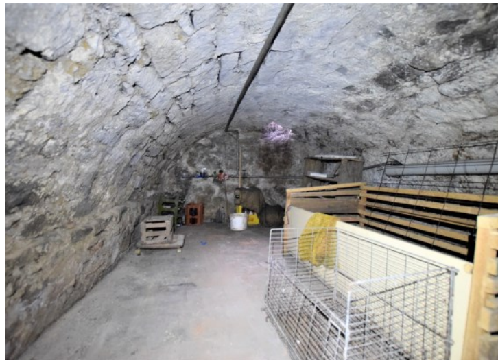
© (Ch. Heitzer) Kleiner Gewölbekeller
