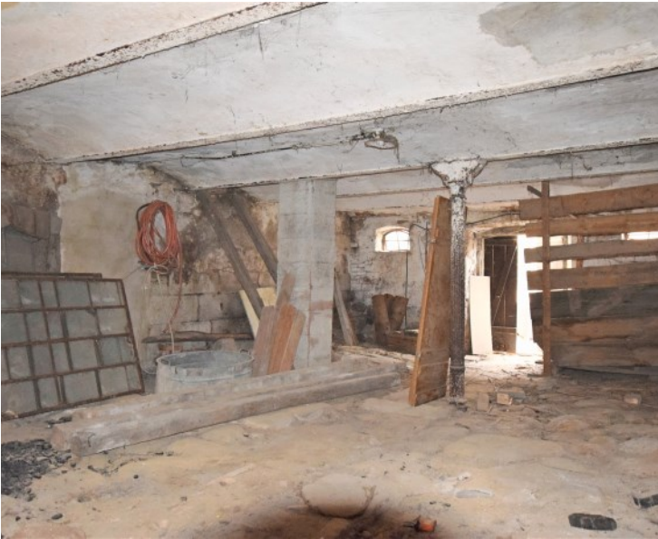
© (Ch. Heitzer) Ausbaufähiger Stallbereich
