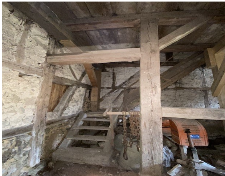
© (F. Noll) Treppe zum Heuboden
