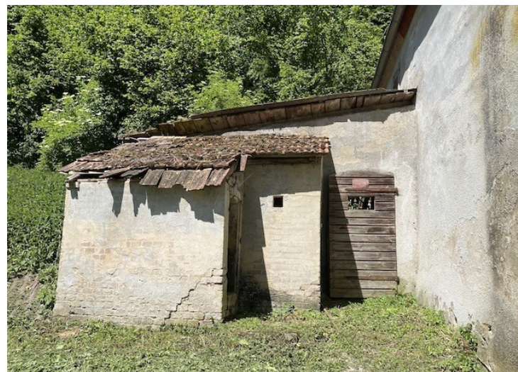
© (F. Noll) Kleine Anbauten an der Westseite
