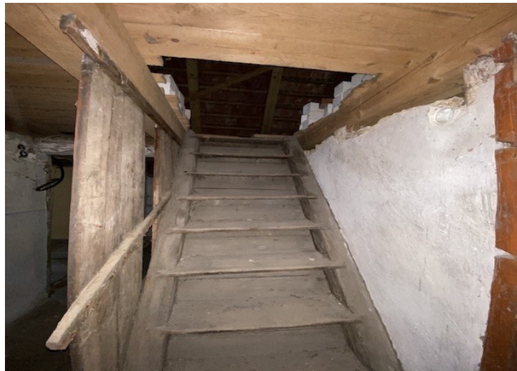
© (F. Noll) Treppenaufgang ins OG
