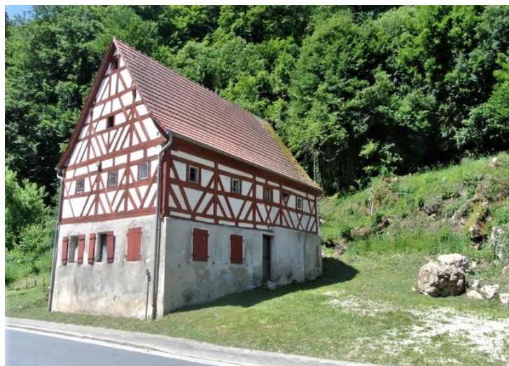
© (F. Noll) Ansprechendes Wohnstallhaus mit reizvoller Fachwerkfassade
