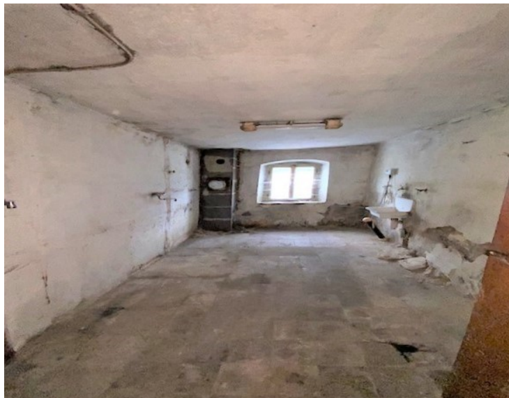
© (F. Noll) Ehemalige Küche im EG
