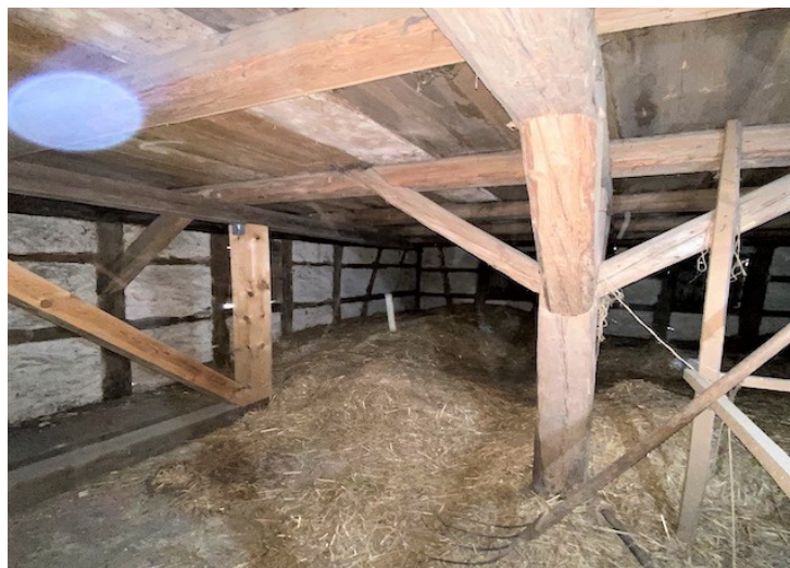
© (F. Noll) Großzügiger Heuboden im OG
