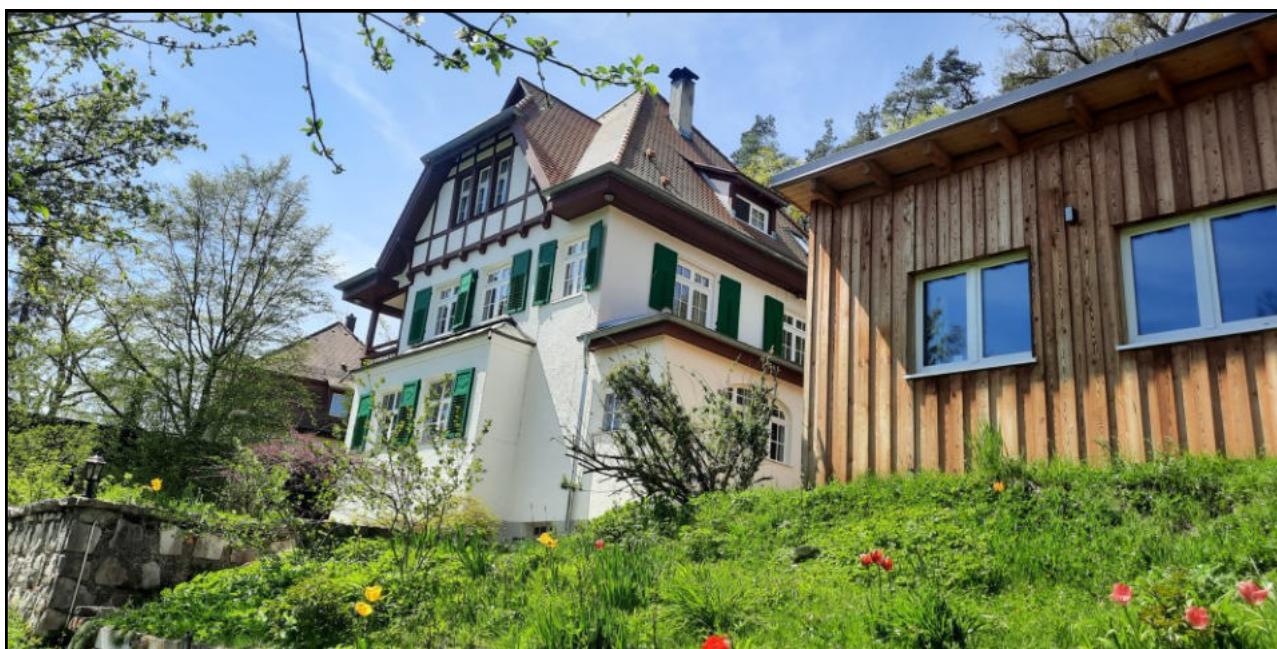
© (F. Knabe) Atemberaubende Villa mit vielseitig nutzbarem Nebengebäude und reizvollem Parkgrundstück
