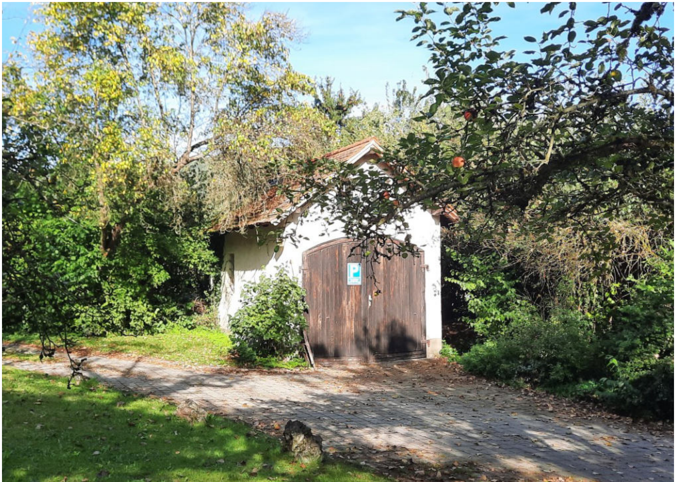
© (F. Knabe) Kleine, denkmalgeschützte Garage mit Werkstattgrube
