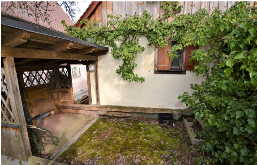
© (G. Gronauer) Freisitz im hinteren Grundstücksbereich
