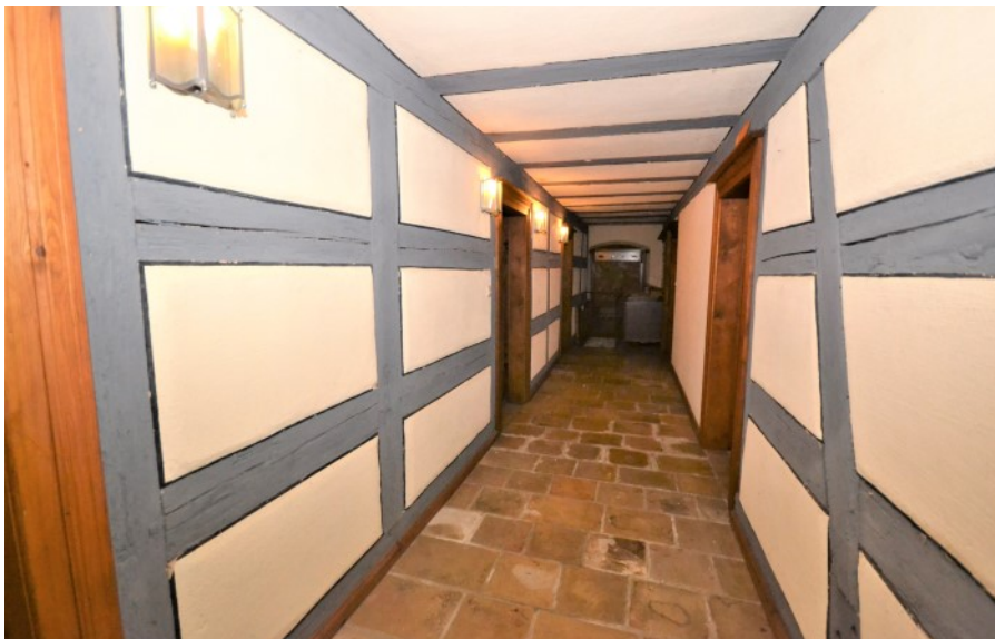
© (G. Gronauer) Flur im EG mit Solnhofner Platten
