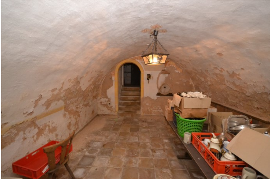
© (G. Gronauer) Historische Gewölbetonne
