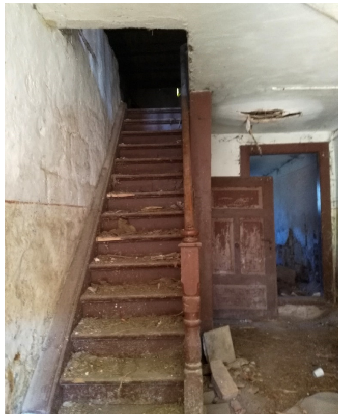
© (EdA) Treppenaufgang ins Dachgeschoss
