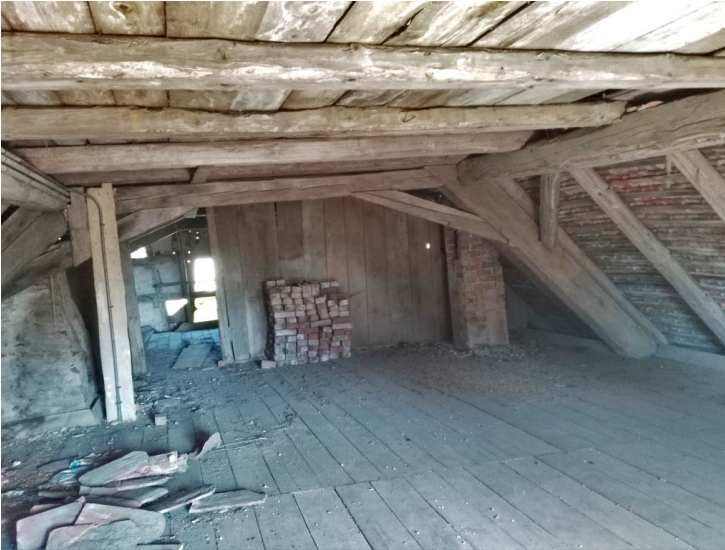
© (EdA) Historischer Dachstuhl
