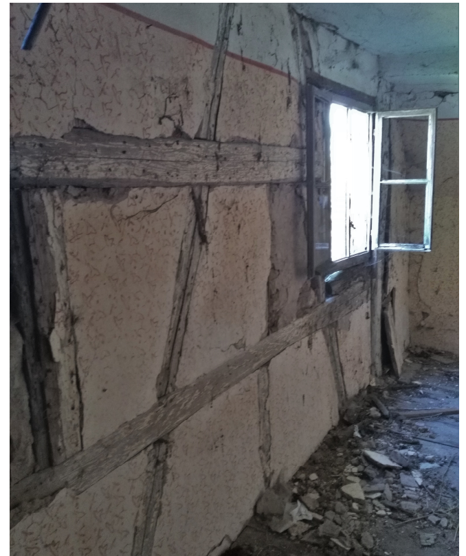
© (EdA) Fachwerk am nördlichen Giebel
