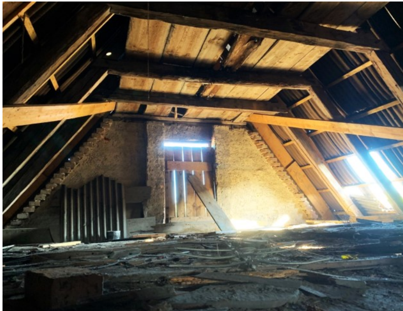
© (M. Jackermeier) Historischer Dachstuhl
