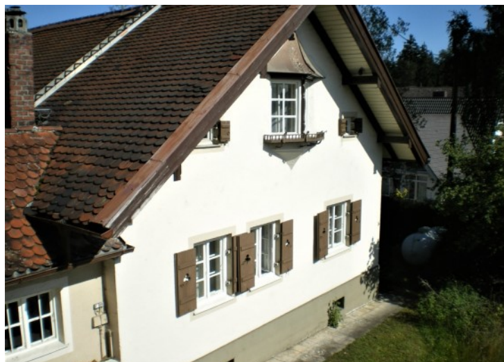
© (BLfD) Eindrucksvolle Giebelfassade im Heimatstil
