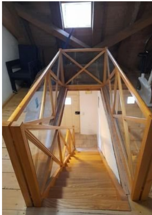
© (F. Mayr) Empore ins ausgebaute DG
