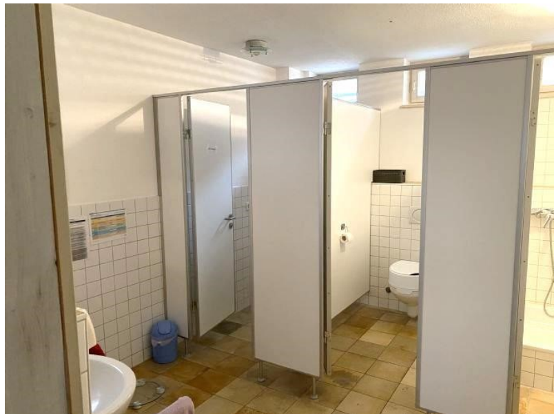
© (F. Mayr) Neugestalteter Sanitärraum mit 3 WCs im EG
