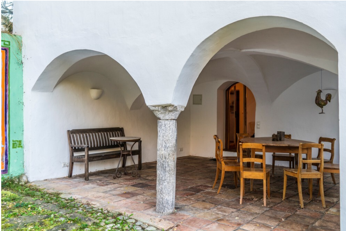
Freisitz mit Kreuzgewölbe
