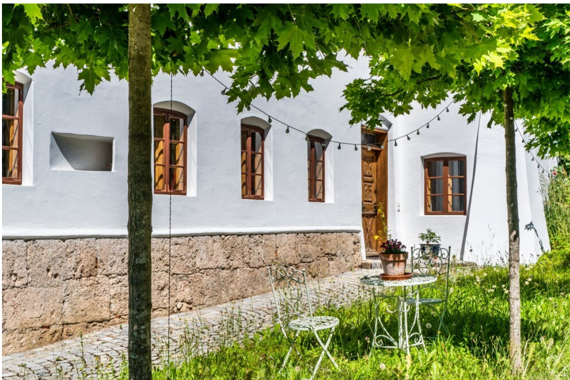
Tuffsteinmauerwerk
