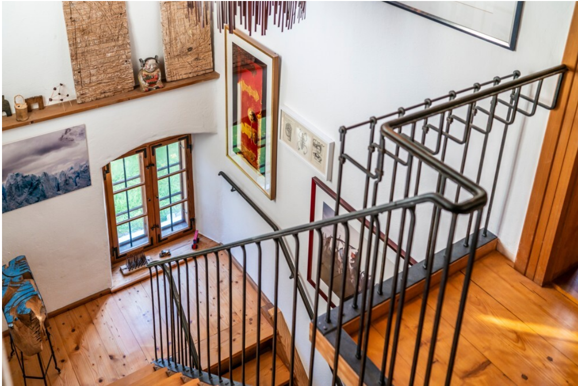
Schmiedeeisernes Geländer im Treppenhaus
