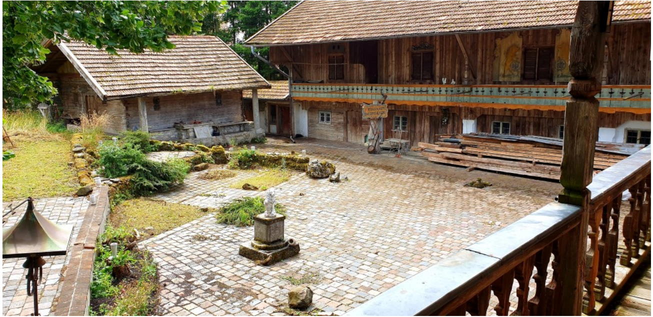
© (M. Hörli) Blick vom Balkon auf den Innenhof und den Getreidekasten
