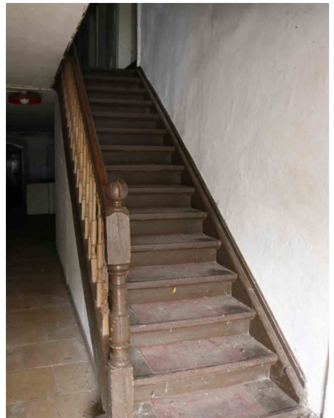
© (E.d.A.) Treppenaufgang ins OG
