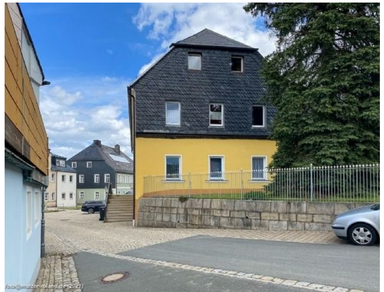
© (R. Mulzer) Teilverschieferte Fassade
