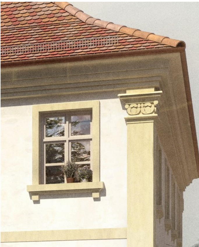
© (I. A.) Eindrucksvoller Eckpilaster nach seiner Sanierung
