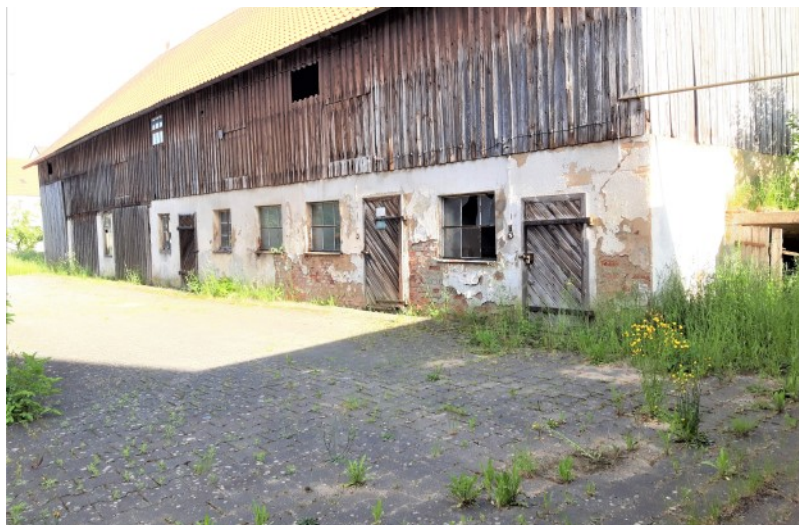
© (M. Fotiadis) Stattliches Wirtschaftsgebäude mit Stallungen und Scheune
