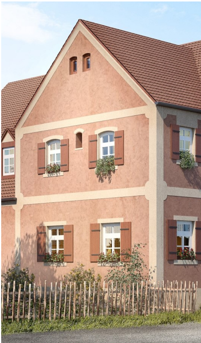
© (L. A.) Darstellung des Zwerchhauses nach seiner Sanierung
