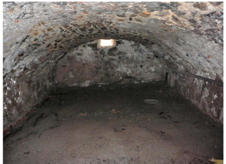
© (M. Beck) Historischer Gewölbekeller
