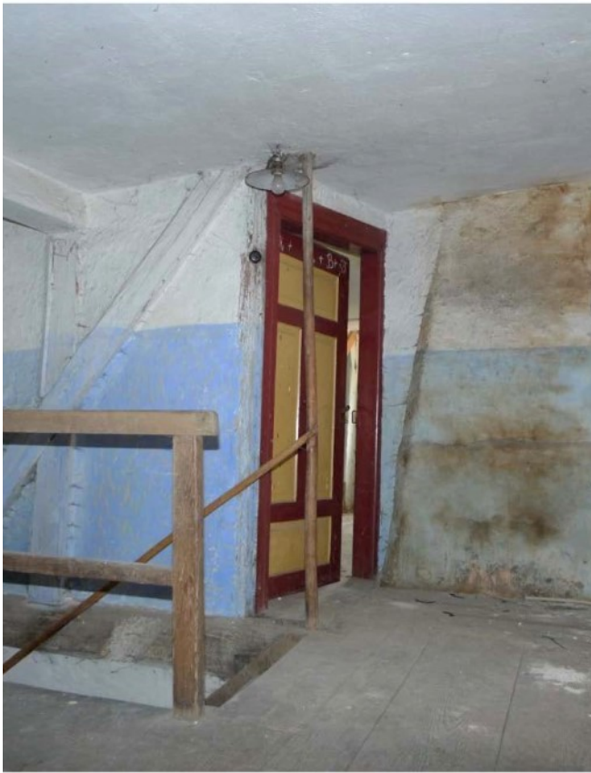
© (M. Beck) Treppenaufgang ins DG
