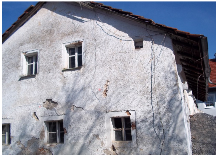
© (EdA) Verputzter Blockbau
