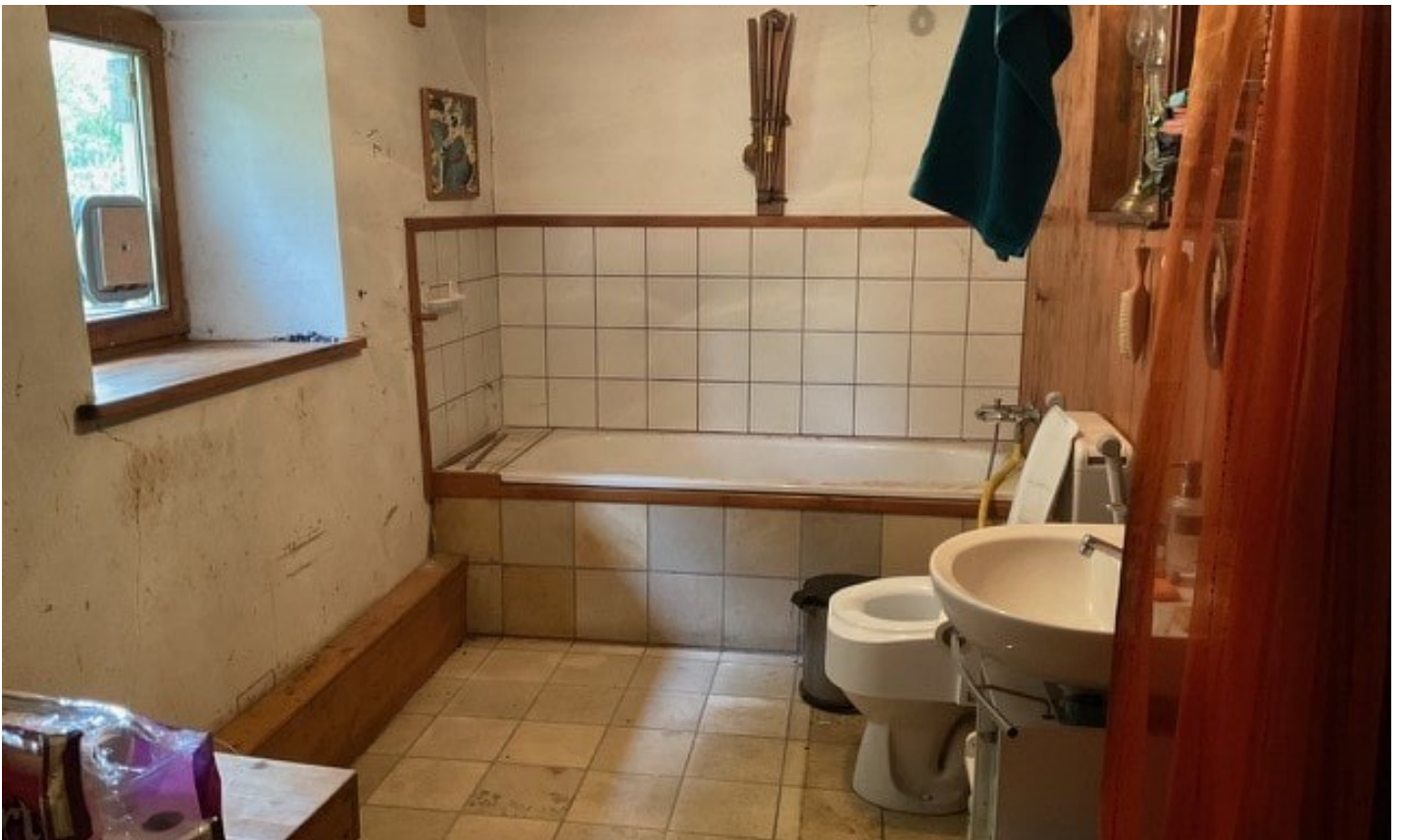
© (E. d. A.) Tageslichtbad mit Badewanne und WC
