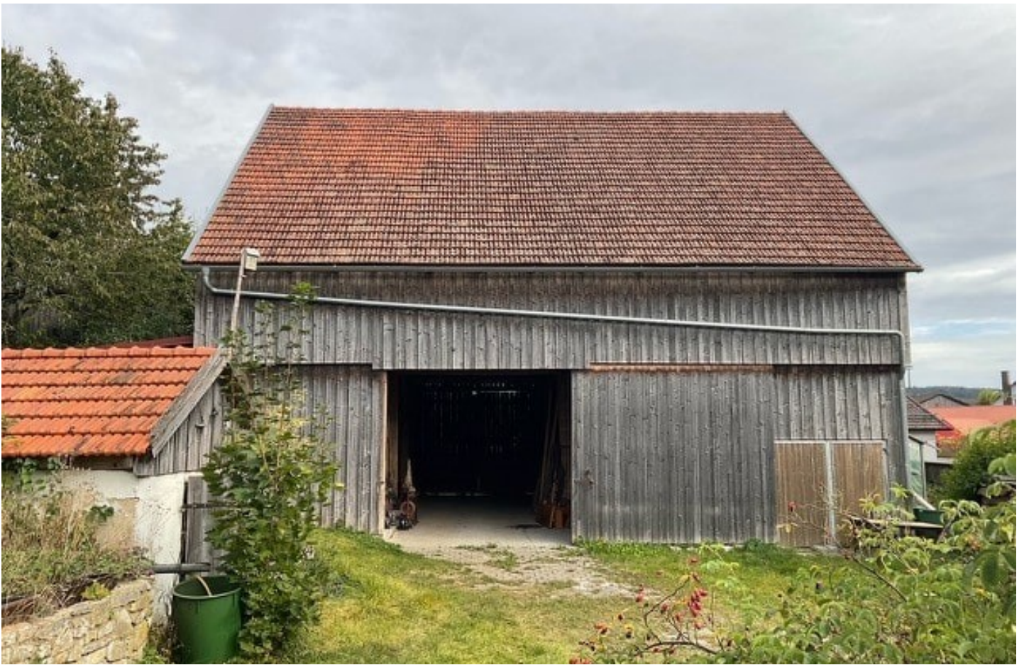
© (E. d. A.) Nicht denkmalgeschützte Scheune
