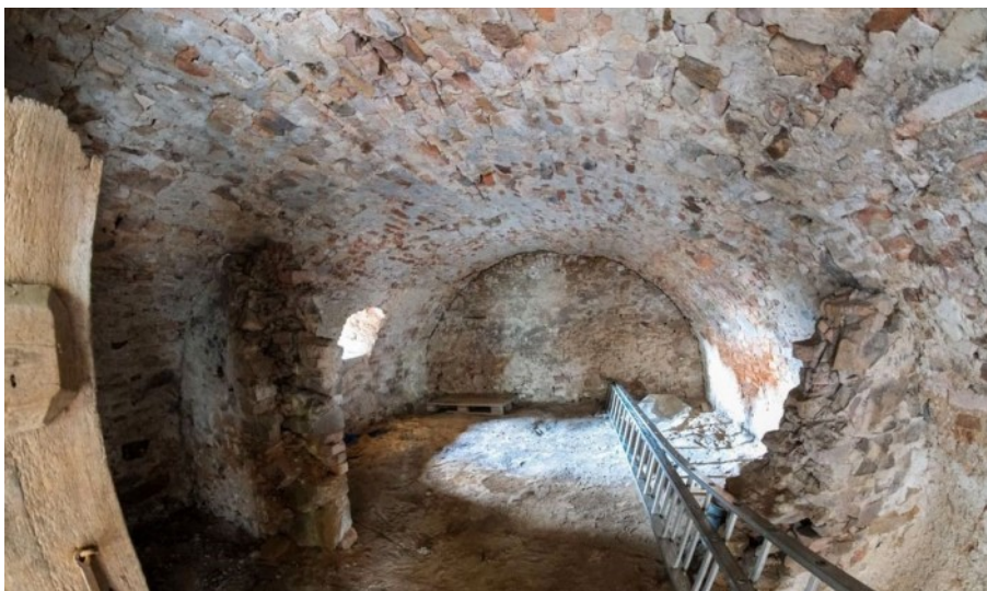
© (F. Weig) Nebenraum mit Tonnengewölbe im linken Gebäudeflügel
