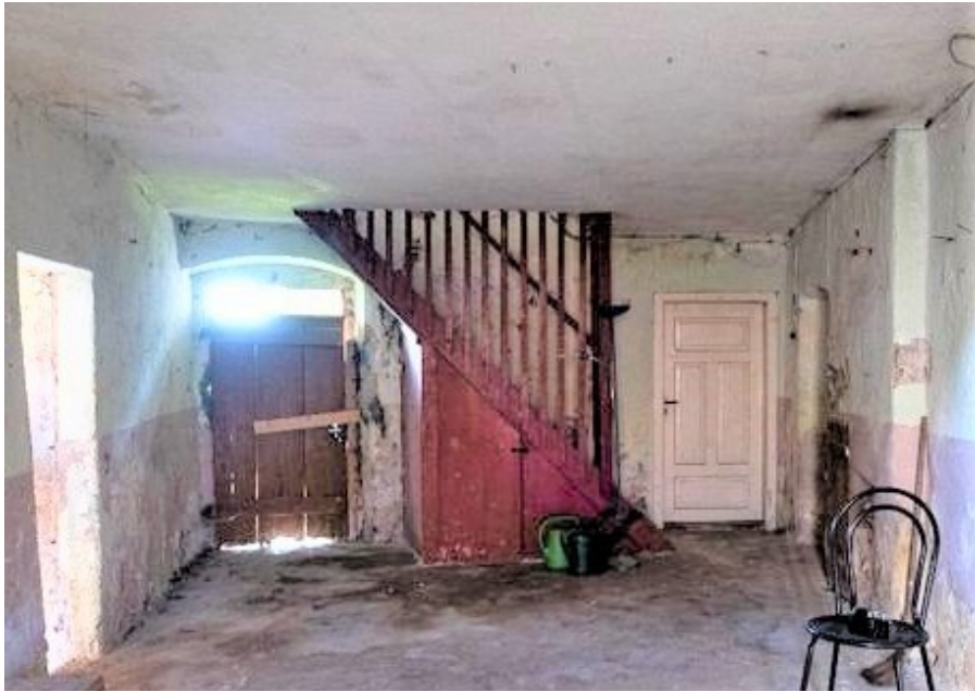
© (F. Weig) Großzügiger Eingangsbereich
