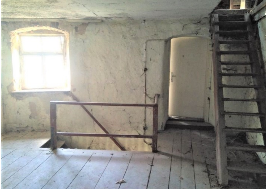
© (F. Weig) Flurbereich und Treppenaufgang im OG
