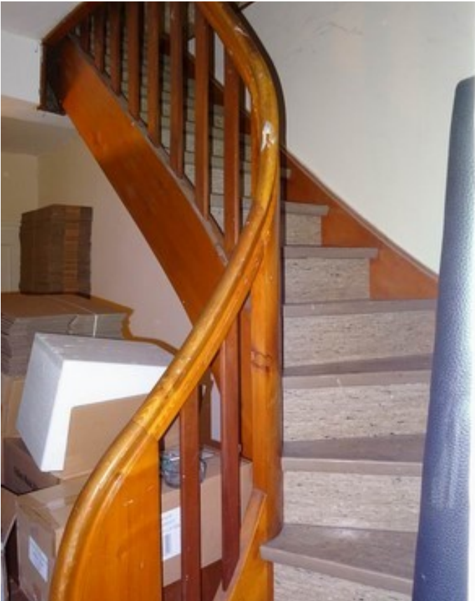
© (D. S. - B.) Moderner Treppenaufgang
