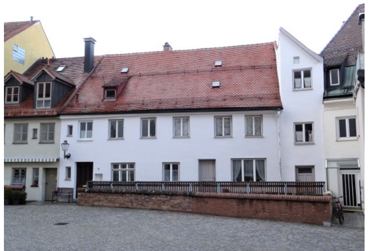
© (D. S. - B.) Rückseite des ehem. Handwerkerhauses
