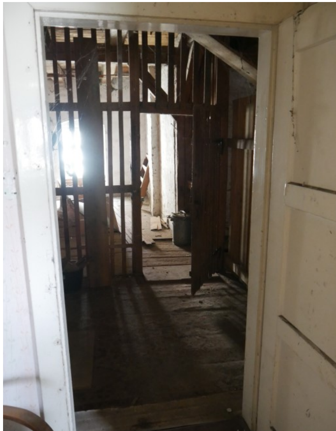
© (FFvGD) Durchgang zur ebenfalls verkäuflichen Nachbarwohnung
