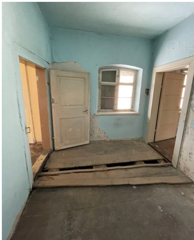
© (S. Eipper) Durchgangszimmer im OG
