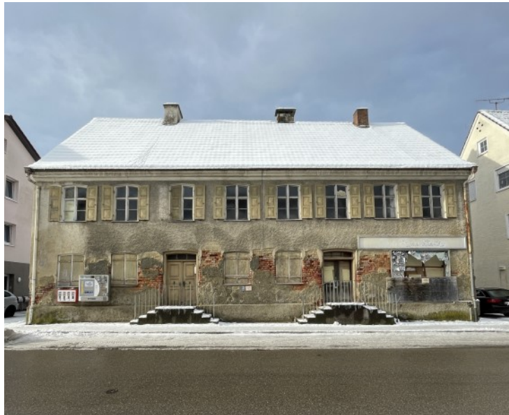
© (S. Eipper) Das Huith-Haus in Altenstadt (Iller)
