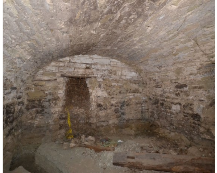
© (G. Gronauer) Tonnengewölbter Keller
