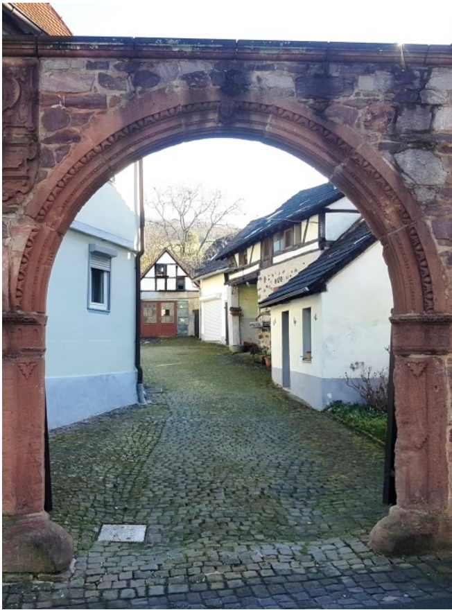
© (Junker Immo) Historischer Sandsteinbogen
