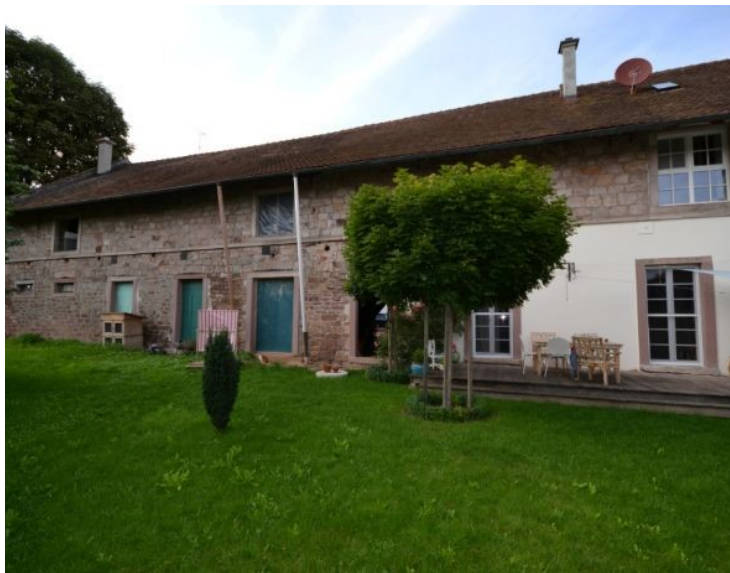
© (G. Gronauer) Attraktives Wohngebäude
