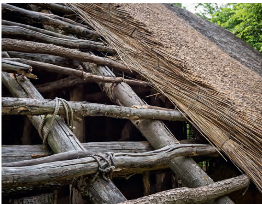
Dachkonstruktion mit Strohabdeckung
