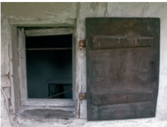
Historisches Fenster; reparaturfähig
