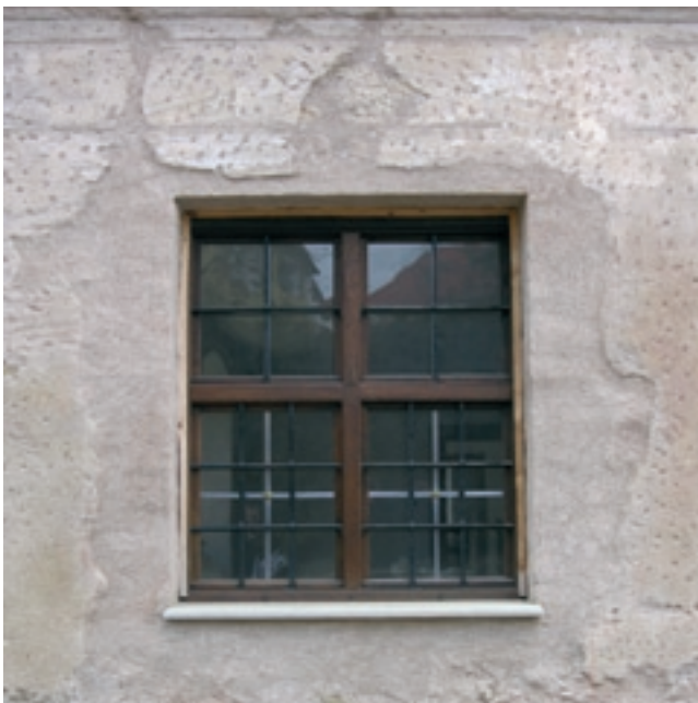
Fenster, Fassadenputz; historischer Bestand bleibt erhalten
