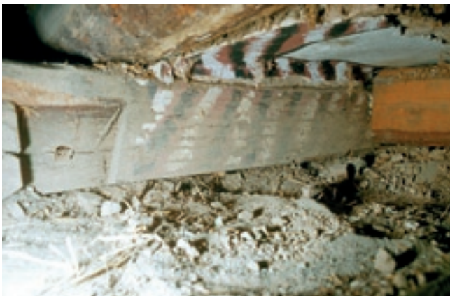
Blick in einen Fehlboden; baugeschichtliche Spurensicherung
