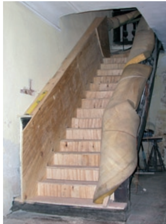
Barocke Treppenanlage; Baustellensicherung
