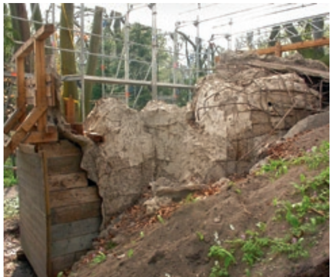
Künstliche Jurahöhle in Erlangen; Ergänzung der historischen Mörtelschale
