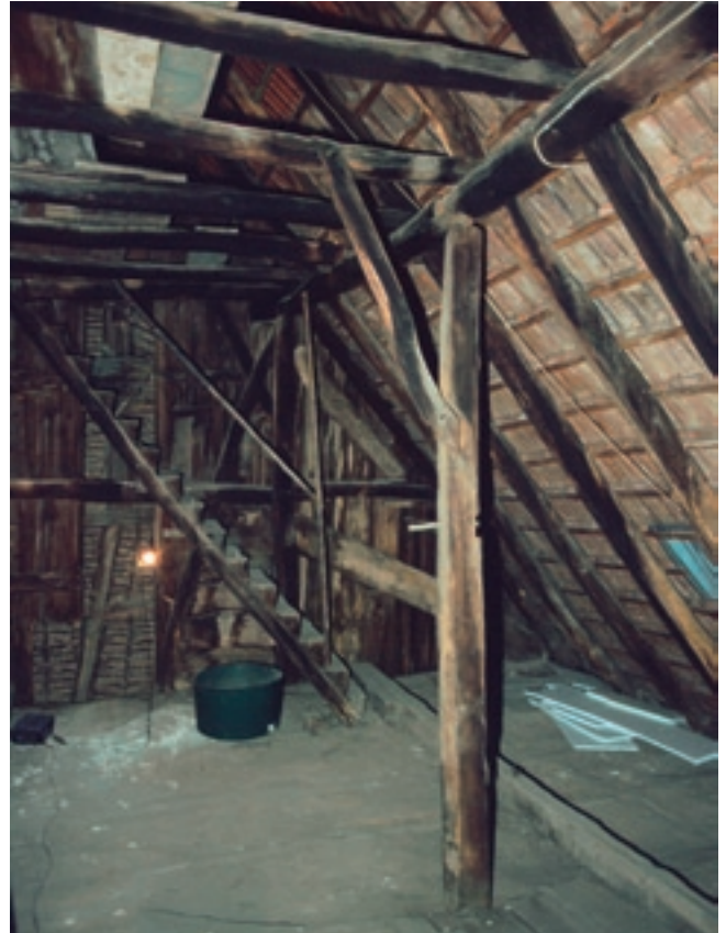
Dachwerk des 14. Jahrhunderts, reparaturfähig
