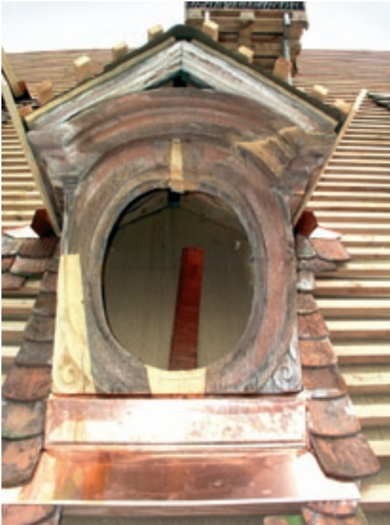
Barocke Dachgaube nach der Reparatur
