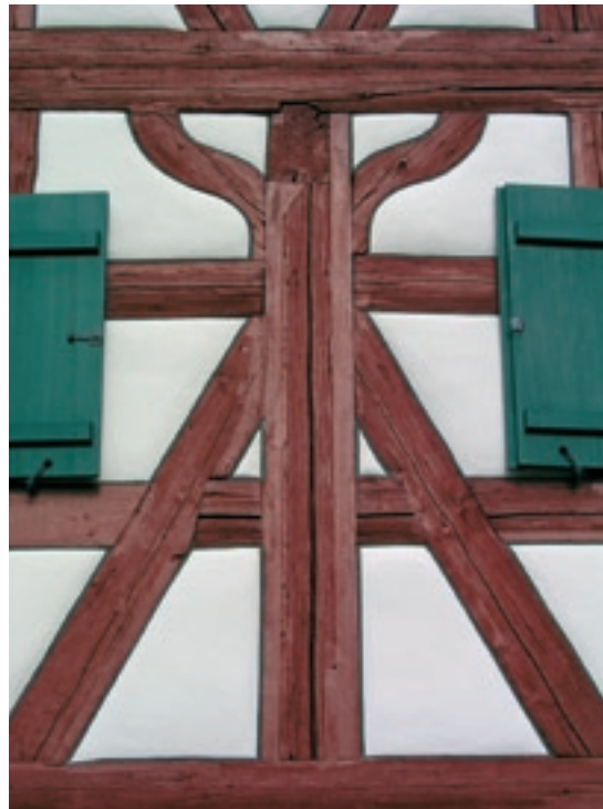
Fachwerkfassade, Reparatur und Wiederherstellung der historischen Farbgebung
