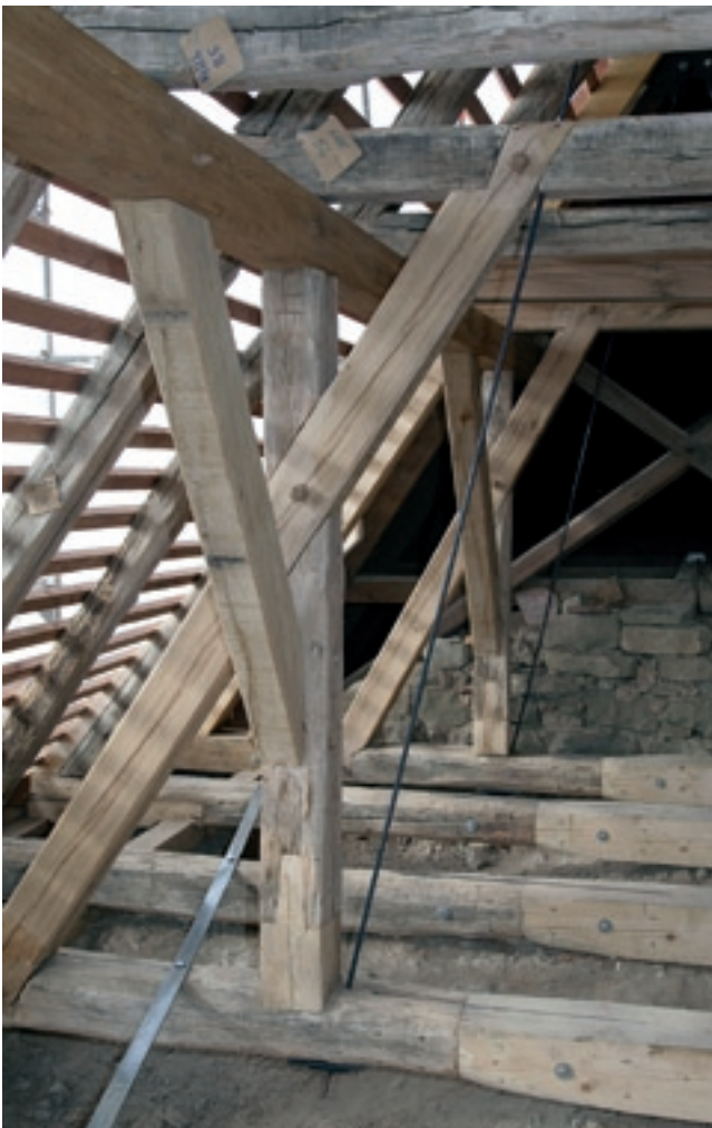
Dachwerk nach Reparatur
