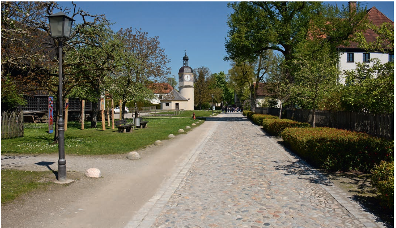
Abb. 30 Barrierefreiheit im öffentlichen Raum: Pflastergestaltung mit ebener (Teil-)Oberfläche im historischen Ensemble (Foto: Klaus-Jürgen Edelhäuser)
