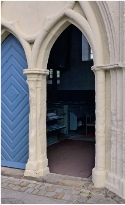
Abb. 55 Barrierefreiheit am historischen Bestand: Angleichung des Innen- und Außenniveaus unter Beibehaltung der historischen Schwelle als Kompromisslösung (Foto: Bernd Vollmar)
