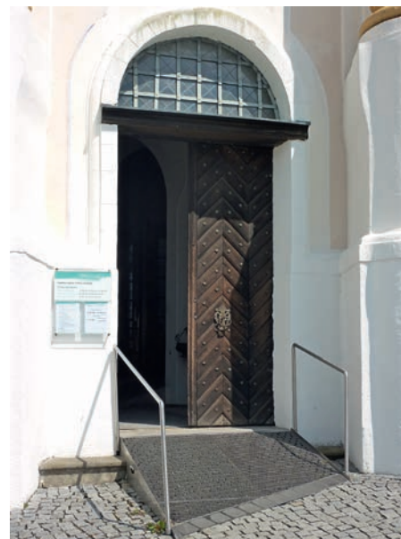
Abb. 45, 46 Barrierefreiheit am Baudenkmals (Welterbe): additive Rampe am Nebeneingang in Kombination mit behindertengerechten Parkplätzen – eine barrierefreie Erschließung des Haupteingangs war hier nicht möglich (Foto: Bernd Vollmar)
