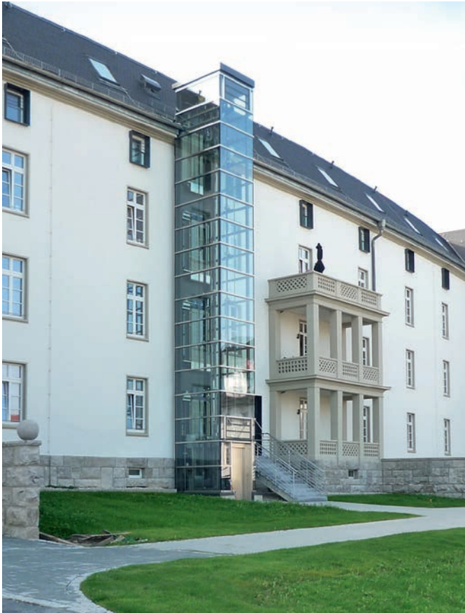
Abb. 67 Barrierefreiheit eines Wohnhauses: additive Aufzugslösung (Foto: BLfD, Robert Pick)
