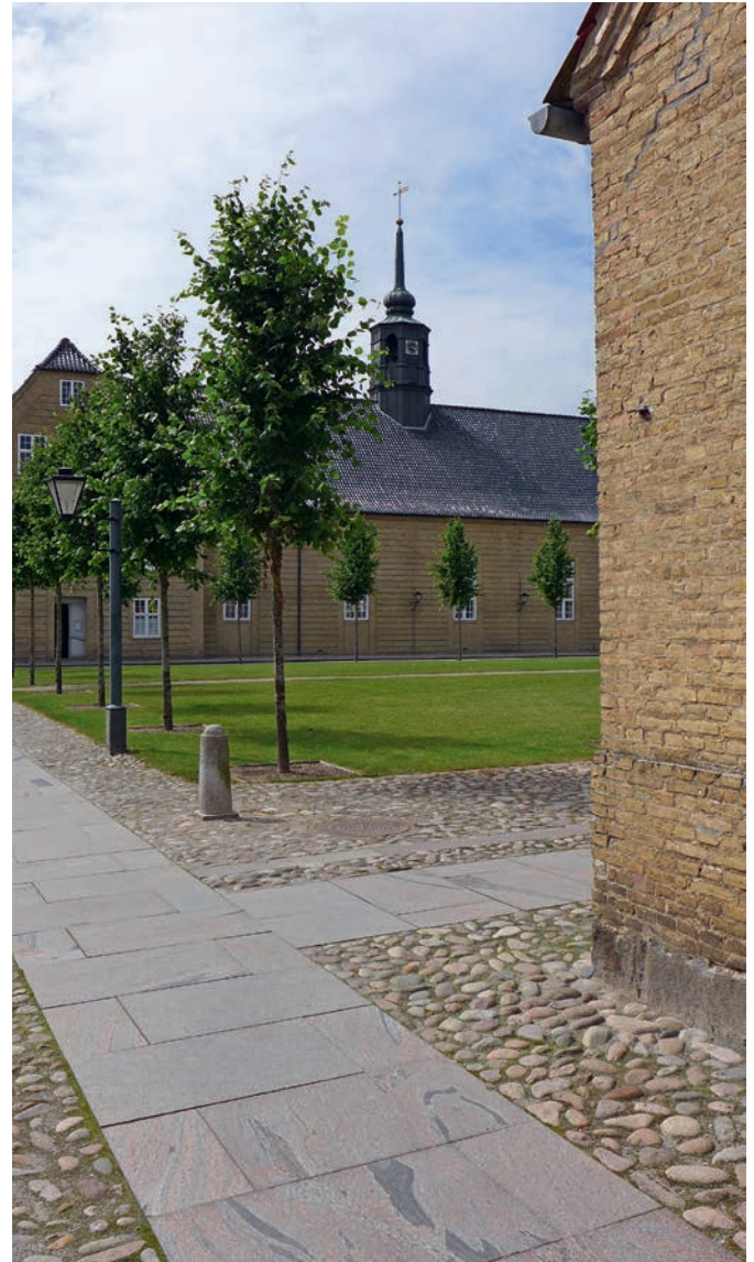
Abb. 37 Barrierefreiheit im öffentlichen Raum: Pflastergestaltung mit weitgehend ebener (Teil-)Oberfläche im historischen Ensemble, jedoch nicht angemessenem Material (Foto: Bernd Vollmar)
