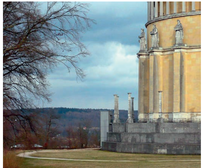
Abb. 65, 66 Barrierefreiheit am Baudenkmal: externe Aufzugserschließung zur Schonung des historischen Baubestands im Inneren (Fotos: Bernd Vollmar)
