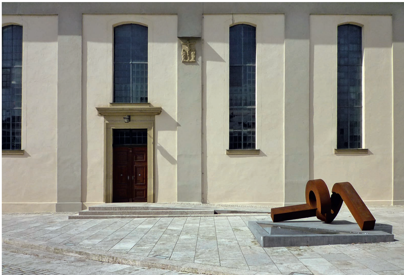
Barrierefreiheit am Baudenkmal: eine in die Treppenstufen und in die Oberflächengestaltung des Platzes integrierte Rampe, gegenläufig zur Geländeneigung (Foto: Bernd Vollmar)
