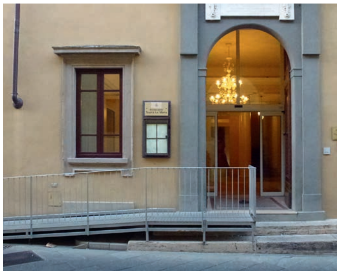
Abb. 10 Barrierefreiheit in der historischen Stadt: additive Rampenlösung mit Erhalt der historischen Stufen (Foto: Bernd Vollmar)
