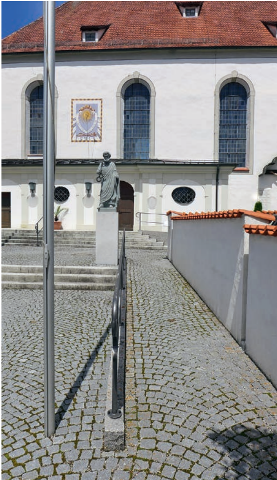
Abb. 60 Barrierefreiheit im öffentlichen Bereich: additive Rampe mit einheitlicher Pflastergestaltung als Kompromisslösung (Foto: Bernd Vollmar)
