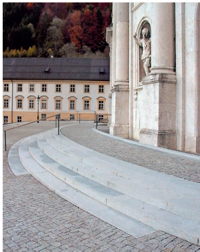
Abb. 47–49 Barrierefreiheit am Baudenkmals: Vorzustand des Kirchenportals (links oben) und Zustand nach der barrierefreien Erschließung: vorgelagerte Treppen- und Rampen-Neugestaltung mit integrierter Rampe. Das neue ebenerdige Niveau verdeckt den Sockelbereich des historischen Bestandes (Fotos: Bernd Vollmar)
