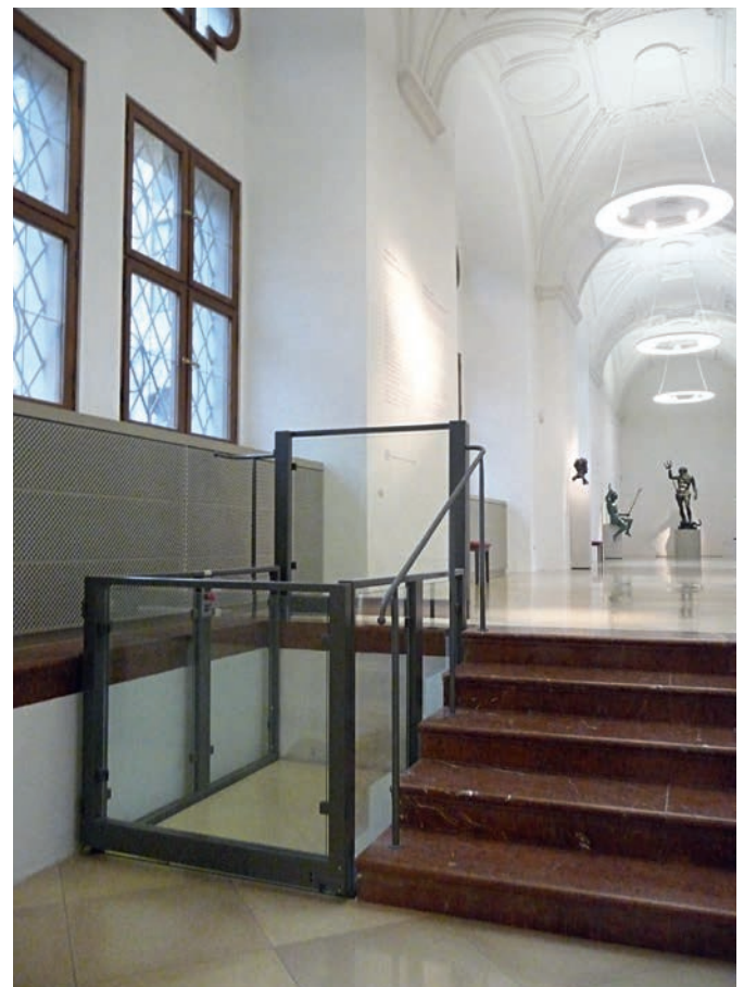
Abb. 21 Barrierefreiheit im musealen Bereich: Hebebühne zur Höhenüberwindung (Foto: Bernd Vollmar)
