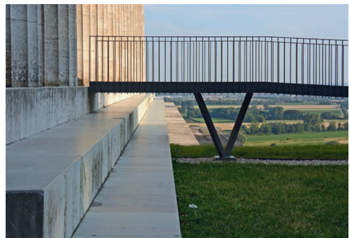
Abb. 61, 62 Barrierefreiheit am Baudenkmal: additive moderne Rampe (Fotos: BLfD, Bildarchiv/Klaus-Jürgen Edelhäuser)
