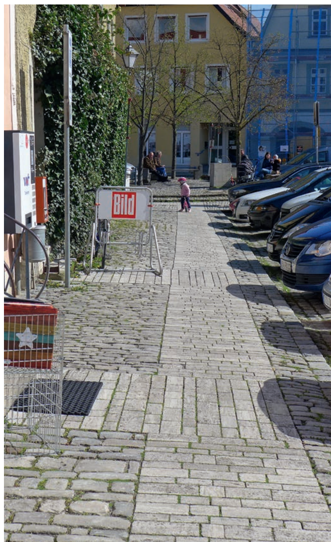
Abb. 35 Barrierefreiheit im öffentlichen Raum: Pflastergestaltung mit weitgehend ebener (Teil-)Oberfläche im historischen Ensemble (Foto: Bernd Vollmar)
