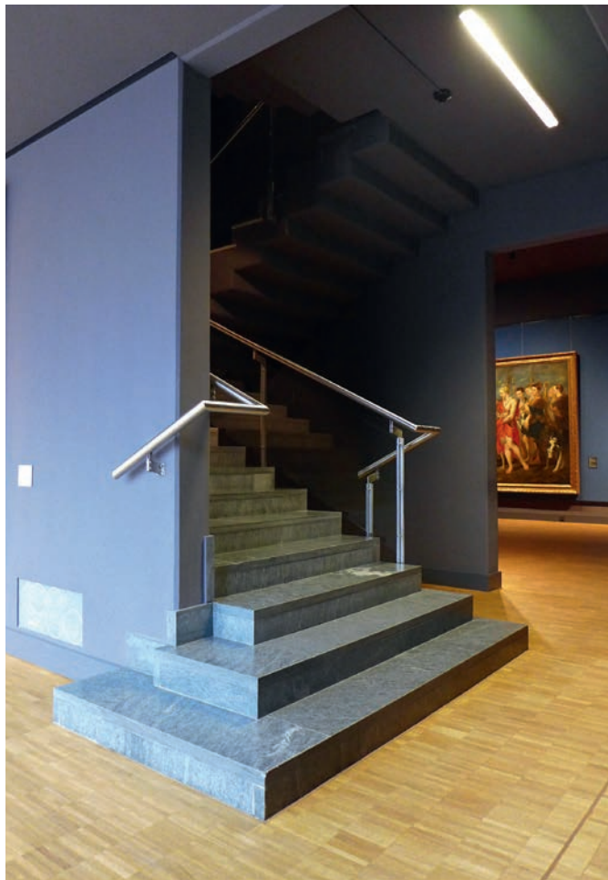
Abb. 17 Barriere im musealen Bereich: moderne Geländergestaltung, jedoch wegen der zu kurz gestalteten Handläufe auch für Menschen ohne Einschränkungen eine Stolperfalle (Foto: Bernd Vollmar)
