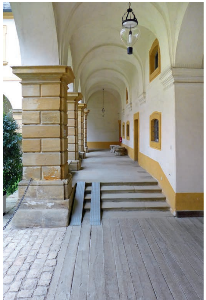
Abb. 59 Barrierefreiheit im museal genutzten Baudenkmal: Kompromisslösung mit zweiteiliger Rampe erfordert Hilfe durch ständig anwesendes Personal (Foto: Bernd Vollmar)
