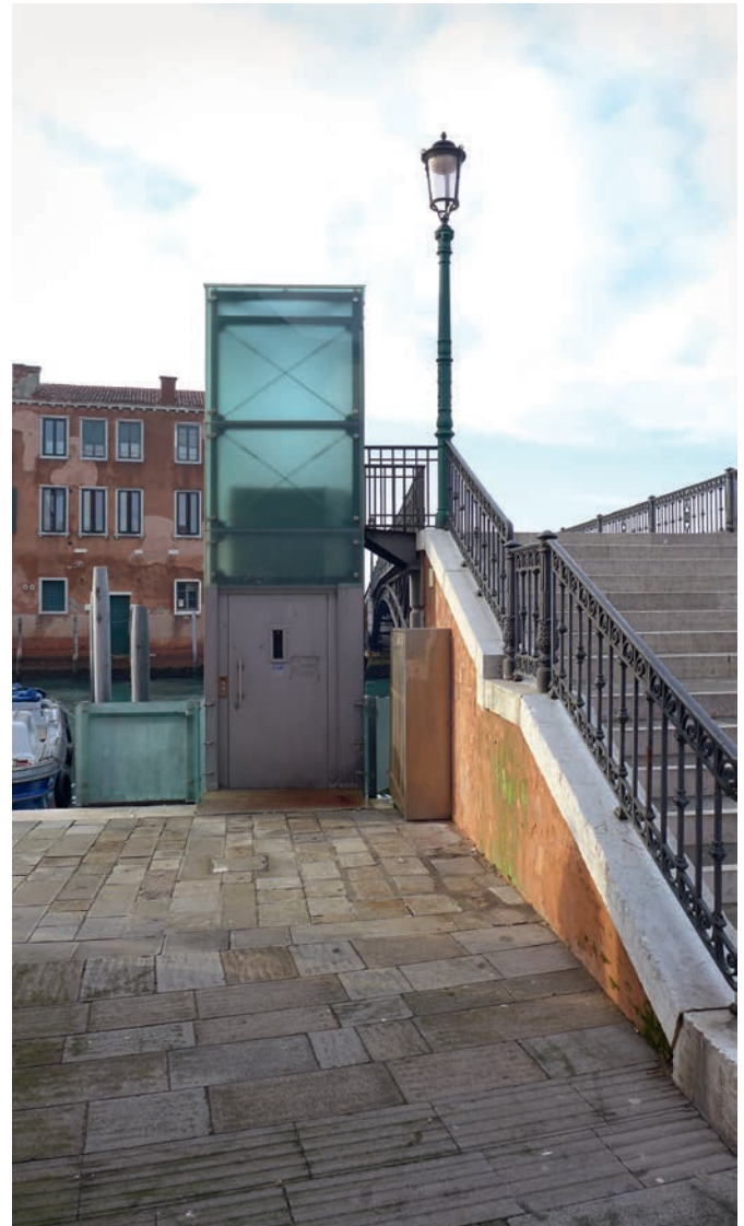
Abb. 6 Barrierefreiheit in der historischen Stadt: aufwendige, aber der historischen Umgebung nicht angemessene Aufzugslösung an einer der unzähligen Brücken in Venedig (Foto: Bernd Vollmar)
