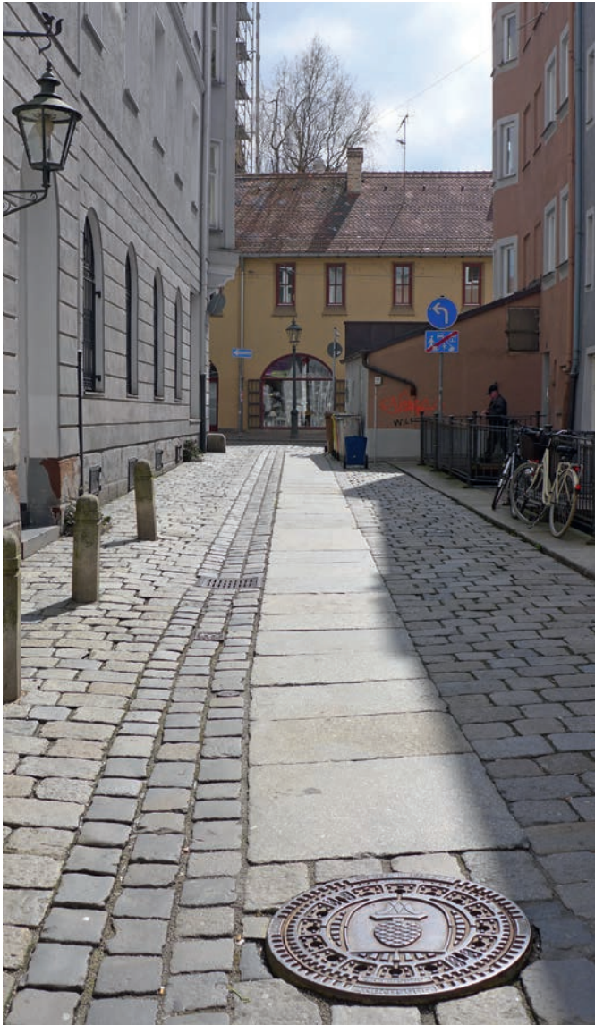
Abb. 36 Barrierefreiheit im öffentlichen Raum: Pflastergestaltung mit weitgehend ebener (Teil-)Oberfläche im historischen Ensemble, jedoch Kanaldeckel als Barriere (Foto: Bernd Vollmar)
