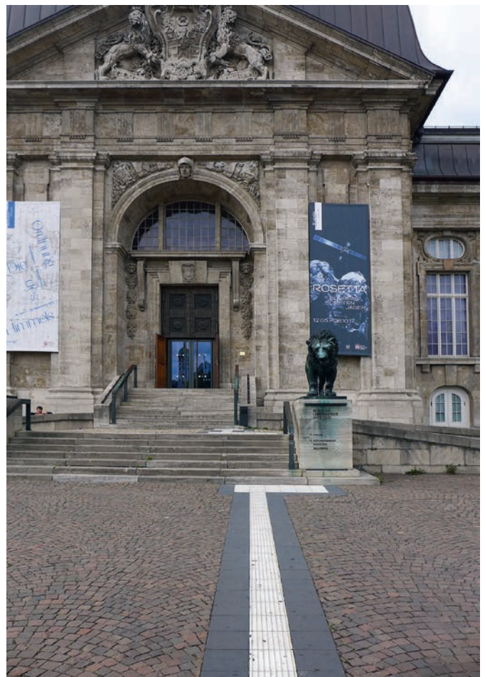
Abb. 27 Barrierefreiheit im öffentlichen Raum: taktile Bodenstruktur vor einem Baudenkmal (Foto: Bernd Vollmar)
