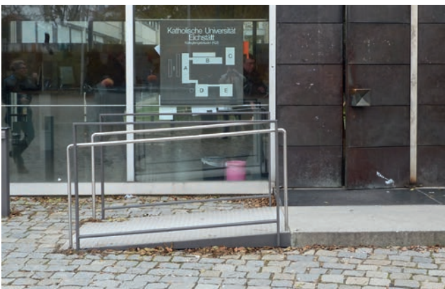
Abb. 57 Barrierefreiheit am modernen Bestandsbau: additiver Niveauausgleich (Foto: Bernd Vollmar)
