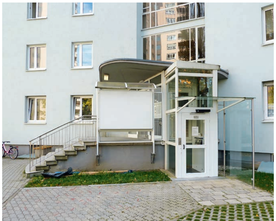
Abb. 77 Barrierefreiheit im Mehrfamilienhaus: additiver externer Aufzug ins Hochparterre (Foto: Bend Vollmar)
