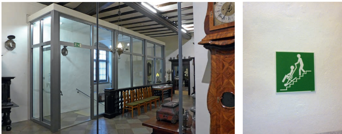
Abb. 9a, b Barrierefreiheit im öffentlich zugänglichen Baudenkmal: Brandschutzabschottung eines Treppenraumes, Piktogramm Evakuierungsstuhl – im Brandfall kann der Aufzug nicht genutzt werden (Fotos: Klaus-Jürgen Edelhäuser)
