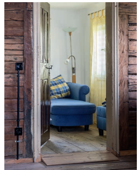
Abb. 85 Schwellen-Niveaueausgleich mit Abschrägung als Kompromisslösung (Foto: BLfD, Michael Forstner)
