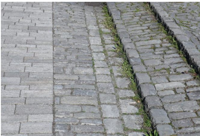
Abb. 38 Barrierefreiheit im öffentlichen Raum: weitgehend einheitliche Pflastergestaltung, jedoch unzureichend ebene (Teil-)Oberfläche im historischen Ensemble (Foto: Klaus-Jürgen Edelhäuser)
