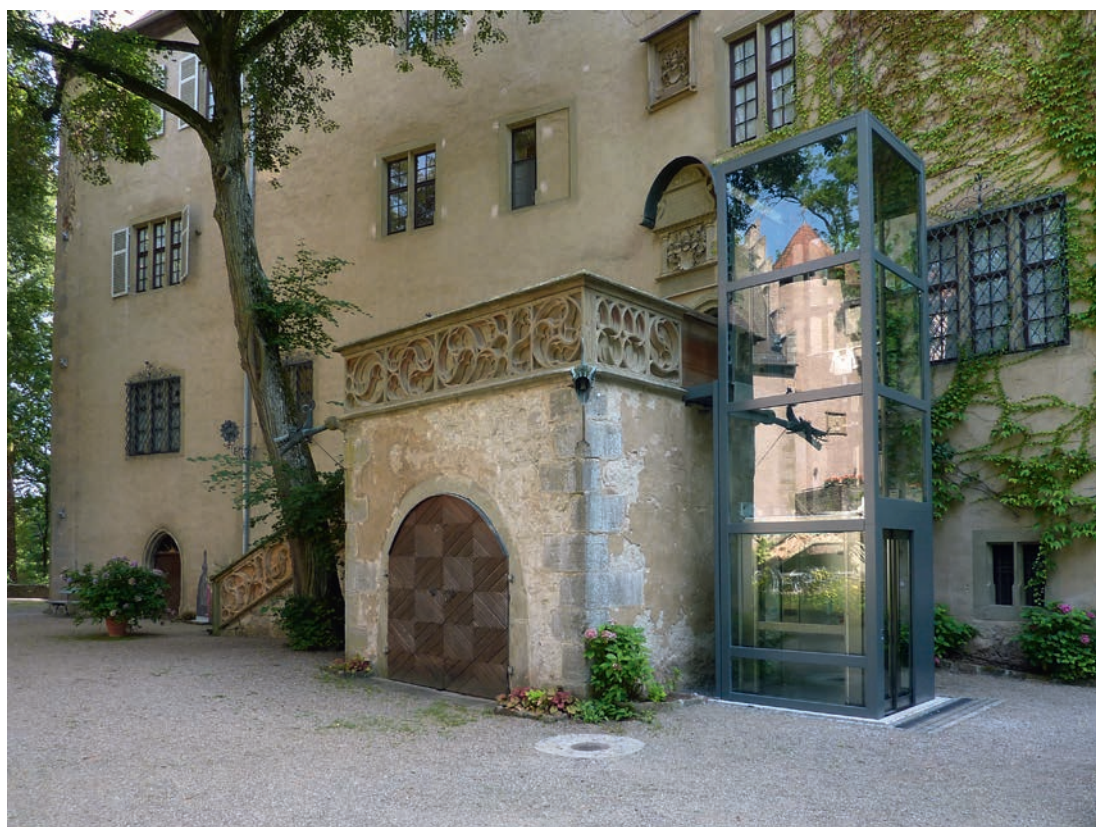
Abb. 71–73 Barrierefreiheit im museal genutzten Baudenkmal: Aufzugmodell im Maßstab 1:1 zur Veranschaulichung der Auswirkungen auf das Erscheinungsbild und Aufzug nach Fertigstellung. Eine großflächige Verglasung kann bei bestimmten Lichtverhältnissen durch Spiegelungen einen massiv wirkenden Baukörper entstehen lassen (Fotos: Klaus-Jürgen Edelhäuser)
