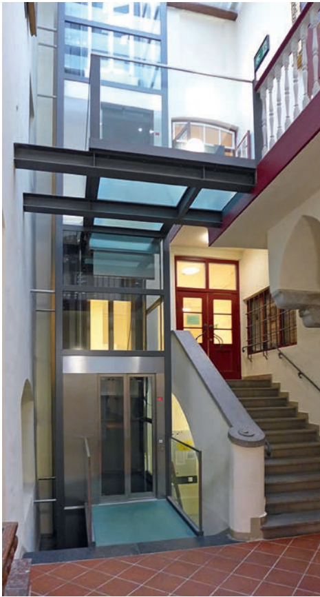
Abb. 74 Barrierefreiheit im denkmalgeschützten, öffentlichen Gebäude: additive Aufzugsanlage in einem ehemaligen Innenhof (Foto: Bernd Vollmar)
