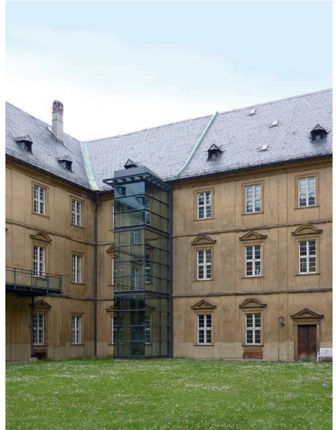
Abb. 68 Barrierefreiheit im seniorengerechten Wohnen: externe Aufzugsschließung und Rettungsbalkon im nicht öffentlich einsehbaren Innenhofbereich (Foto: Bernd Vollmar)
