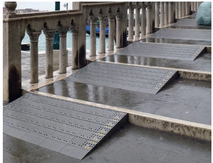
Abb. 7 Barrierefreiheit in der historischen Stadt: endgültige Kompromisslösung einer Rampe mit Anpassung der möglichen Rampenneigung an die örtlichen Gegebenheiten in Venedig (Foto: Bernd Vollmar)
