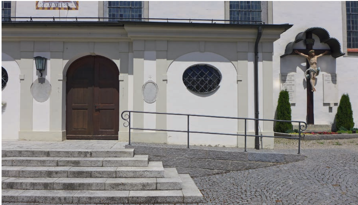
Abb. 12 Barrierefreiheit am Baudenkmal: additive Rampenlösung und Erhalt der historischen Stufengestaltung (Foto: Bernd Vollmar)
