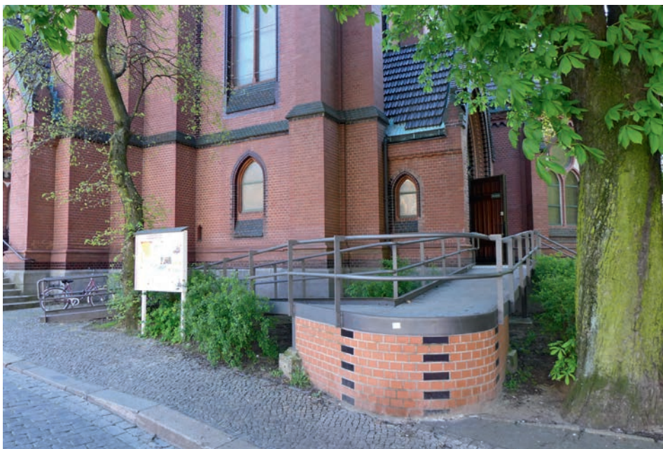
Abb. 54 Barrierefreiheit am historischen Bestand: additive, aufwendig angelegte und mehrfach gekehrte Rampe am Nebeneingang – eine barrierefreie Erschließung des Haupteingangs war nicht möglich (Foto: Bernd Vollmar)
