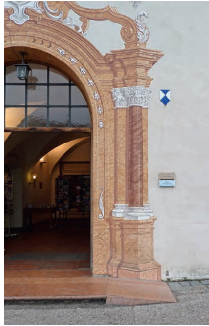
Abb. 56 Barrierefreiheit am Baudenkmal: additive, unauffällige Rampenlösung (Foto: Bernd Vollmar)
