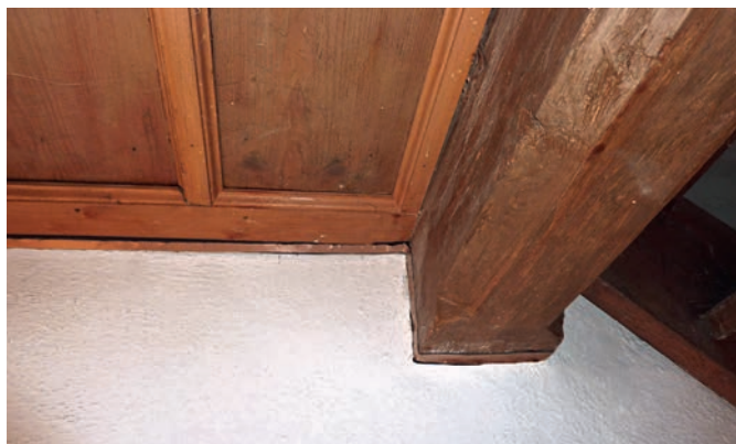
Abb. 25 Barrierefreiheit im kirchlichen Bereich: „induktive Schleife“, verlegt an einer historischen Deckenkonstruktion (Foto: Klaus-Jürgen Edelhäuser)
