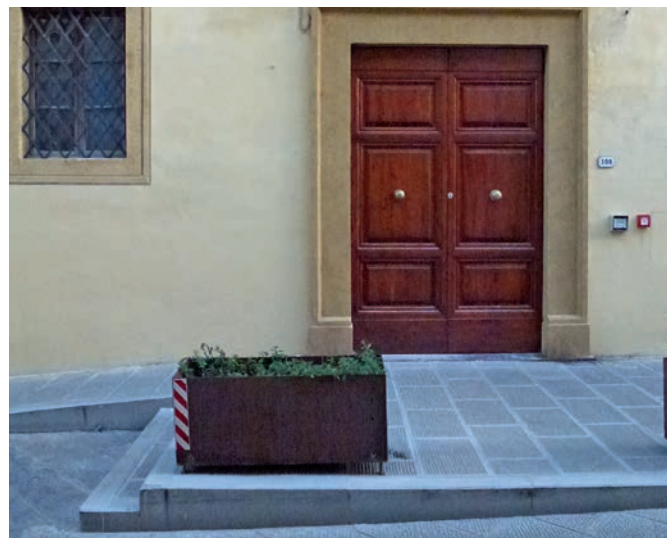
Abb. 11 Barrierefreiheit in der historischen Stadt: Rampen- und Stufenlösung als Ersatz für die bauzeitliche Erschließung (Foto: Bernd Vollmar)
