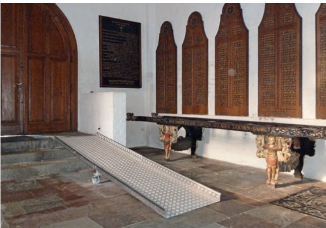
Abb. 58 Barrierefreiheit im kirchlichen Bereich: Kompromisslösung mittels mobiler Rampe neben historischer Bäre (Foto: Bernd Vollmar)
