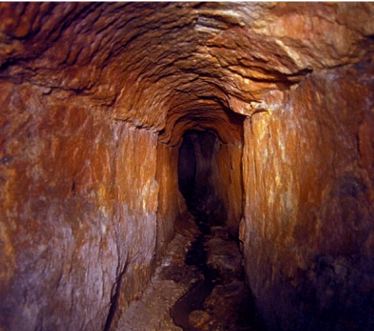
Stollenanlage unter der Alten Spinnerei (Foto: BLfD, Bernhard Häck, 2010)
