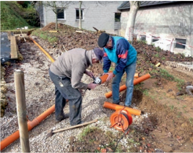
Verlegung der Drainage (Foto: Walter Schraml, 2010)
