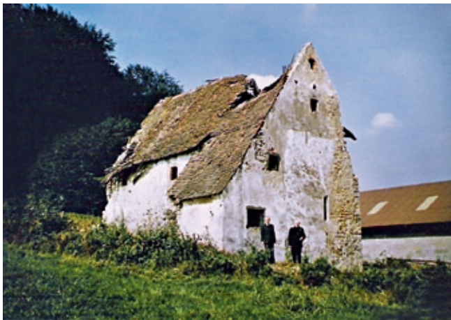
Ermhof, Lkr. Amberg-Sulzbach; St. Martin vor dem Abbruch (Foto: Walter Schraml 1979)
