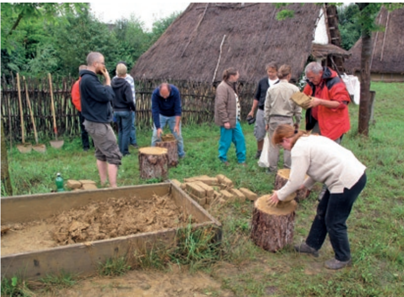
Vorbereitende Arbeiten am Samstag: Herstellen von Lehmziegeln für den Bau der Öfen (Foto: Anja Pütz, 2010)
