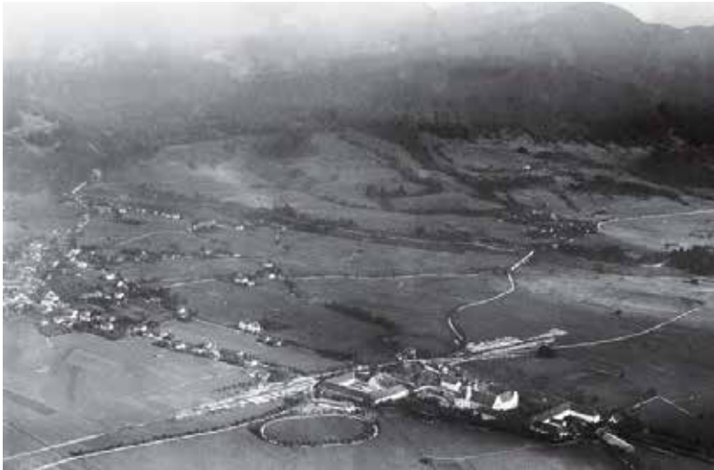
Benediktbeuern. Luftaufnahme (von Nordwesten) des Klosters mit „Hippodrom“ im Vordergrund. Aufnahmedatum vermutl. Anfang 1950 (Foto aus: Fraunhofer-Gesellschaft [Hrsg.], Fraunhofer in Benediktbeuern – Glashütte und Werkstatt, München 2008, S. 7)
