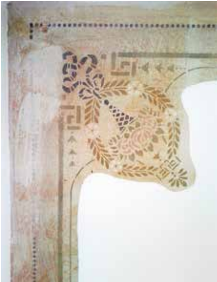
Sonnefeld, Wohnhaus, Schablonenmalerei, bei der Instandsetzung entdeckt und belassen
