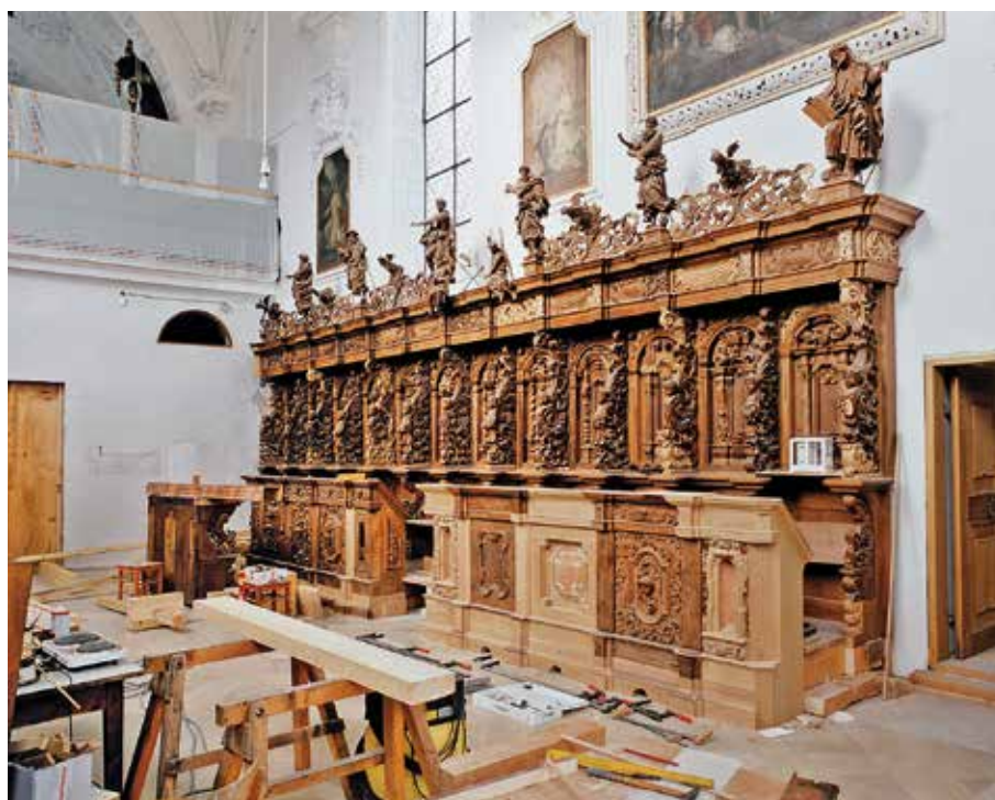
Buxheim, Kartause, Chorgestühl. Der Restaurierungszwischenzustand beim Wiedereinbau zeigt Ergänzungen der durch Transferierung und Umbau verlorenen Teilstücke (Foto: BLfD, Edmund Melzl)
