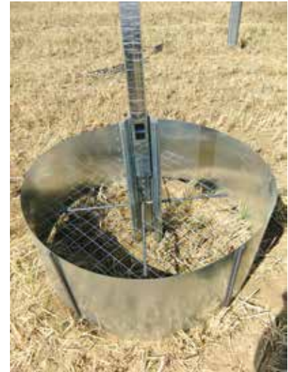
Uffenheim-Wallmersbach, Blechring als Gussform für die Betonmanschetten (Foto: BLfD, Martin Nadler).
