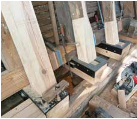
Bamberg, Aufseßhöflein, Reparatur des Dachwerks von 1723, 2013 (Foto: BLfD)
