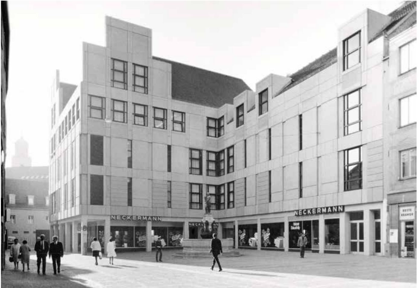
Augsburg, Bürgermeister-Fischer-Str. 6–10, ehem. Kaufhaus Neckermann, heute Karstadt (Foto: Architekturmuseum Schwaben der TU München)
