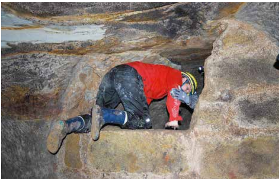
Im Zuge des Studienprojektes musste die Studiengruppe auch in die Kelleranlage unter dem Spitalhügel (Fotos: Stefan Hedler)
