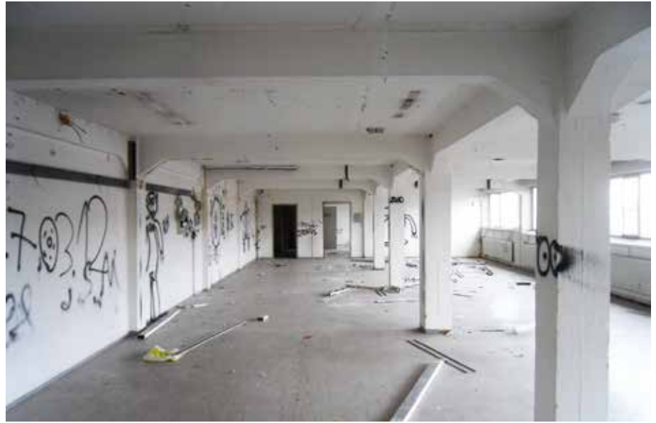
Ingolstadt, ehem. Körnerrieselmagazin, 2. Obergeschoss (Foto: Barthel & Maus, Jörg Rehm)
