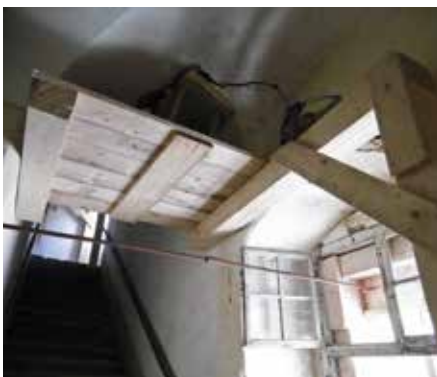
Statische Notsicherung im Ostflügel, 2015
