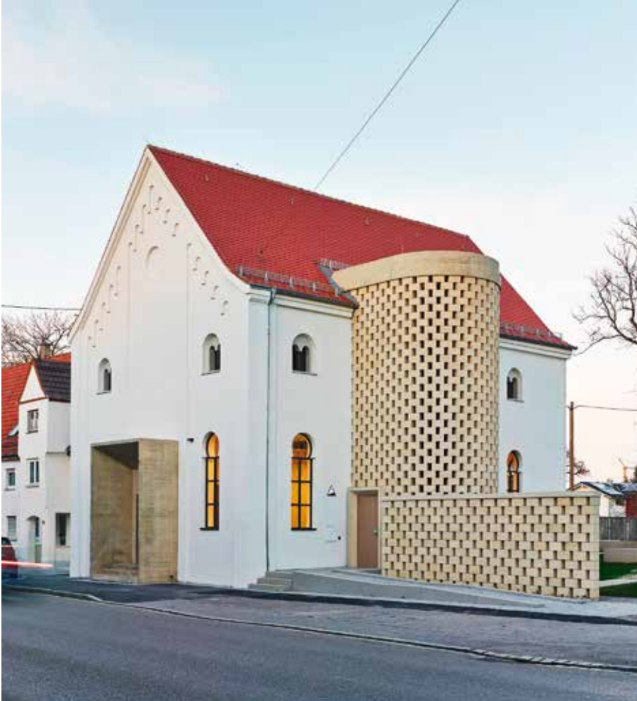
Fellheim, ehem. Synagoge, Ansicht von Südwesten nach Abschluss der Instandsetzungsarbeiten (Foto: Julia Schambeck, München)
