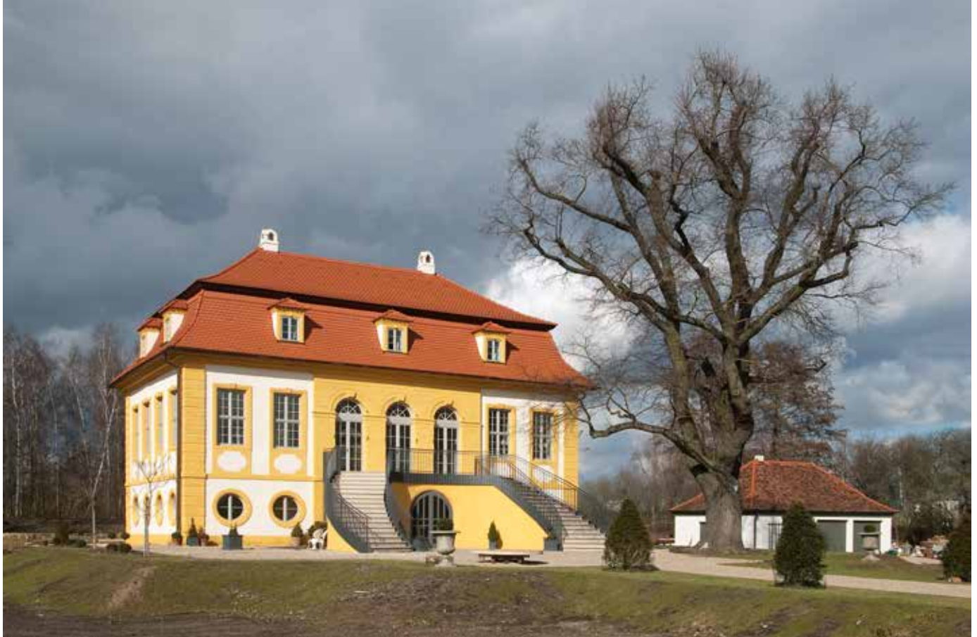
Bamberg, Aufseßhöflein, nach der Instandsetzung (Foto: BLfD, Eberhard Lantz)
