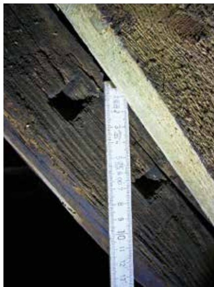
Abbildzeichen mit Käftchen. Hier der hofseitige Sparren von Gespärre Nr. 2 (Foto: Volker Rößner, 2015)
