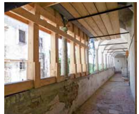
Statische Notsicherung im obersten Arkadengang des Westflügels, 2015
