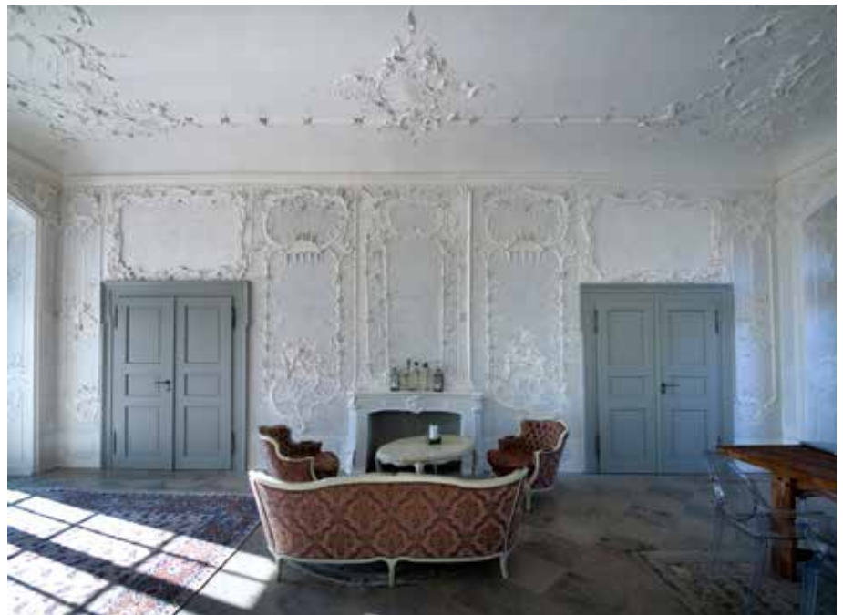
Bamberg, Aufseßhöflein, Festsaal mit Stuckaturen des 18. Jahrhunderts nach der Instandsetzung (Foto: BLfD, Eberhard Lantz)
