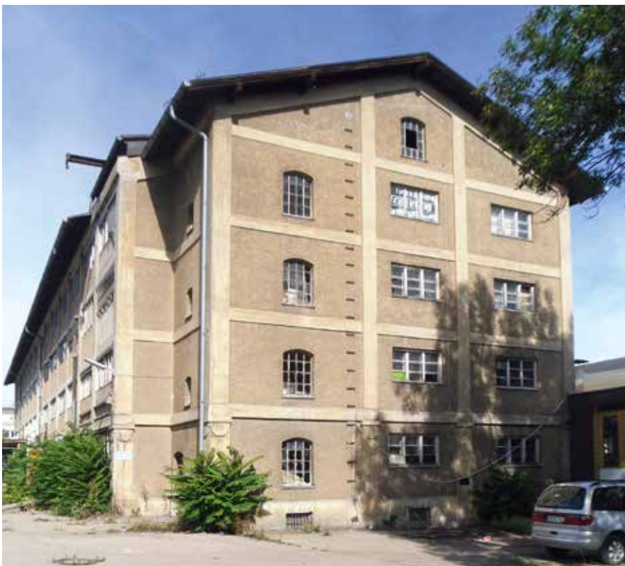
Ingolstadt, ehem. Körnerrieselmagazin, Südostfassade (Foto: BLfD)
