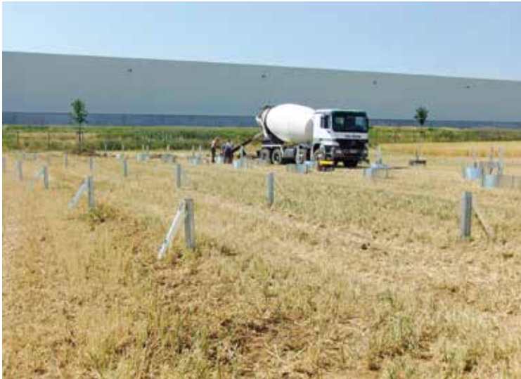
Uffenheim-Wallmersbach, maschineller Ausguss der Betonmanschetten (Foto: BLfD, Martin Nadler)
