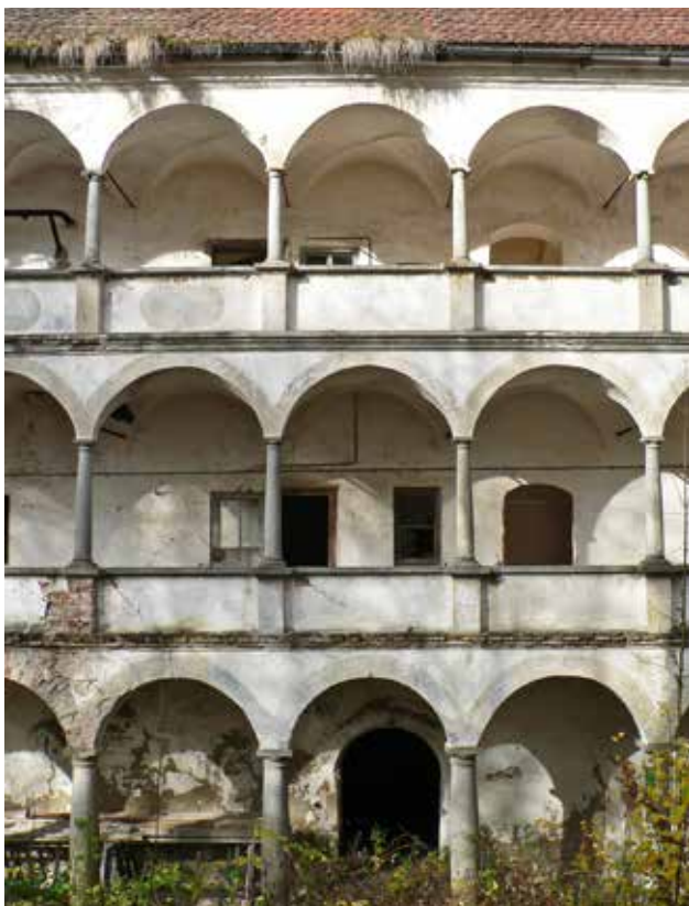
Blick vom Hof auf die bereits überwucherten Arkadengänge des Westflügels, Zustand vor der statischen Notsicherung, 2010
