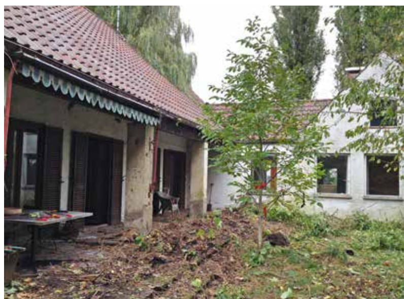
Dorfen, Wohnhaus, Südansicht vor der Instandsetzung (Foto: BLfD, Hildegard Sahler)
