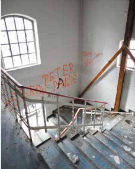
Ingolstadt, ehem. Körnerrieselmagazin, Treppenhaus (Foto: BLfD, Viktoria Lukas-Krohm)
