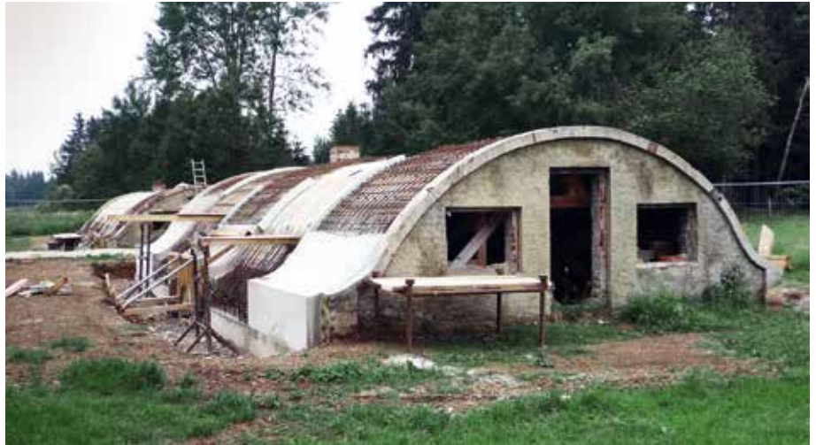
Zwei der erhaltenen Tonröhrenbauwerke im Zwischenzustand während der Aufbetonierung der neuen Betonhülle (Foto: Franz Hölzl, München)
