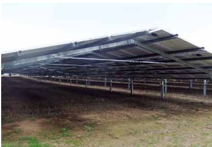
Uffenheim-Wallmersbach, fertiggestelltes Solarfeld auf eingerammten Profilständern (Foto: BLfD, Martin Nadler)
