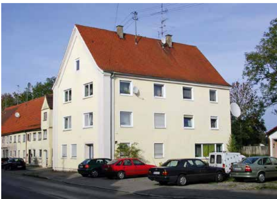
Fellheim, ehem. Synagoge, Zustand vor Beginn der aktuellen Rückbau- und Instandsetzungsarbeiten (Foto: Förderkreis Synagoge Fellheim e. V.)
