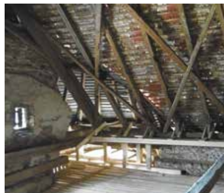
Tragwerksituation über dem Ostflügel, Zustand nach der statischen Notsicherung, 2015
