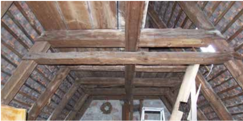
Nürnberg, Loher Hauptstraße 102. Hier wird ein Unterzug zwischen zwei Kehlbalken geklemmt. Allerdings datiert diese Konstruktion von 1596 (d), ist also 200 Jahre jünger als die Lösung in Bamberg (Foto: Georg Brütting, 2015)
