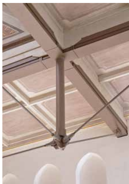
Detailausbildung eines der vier Knotenpunkte in den Kuppellecken (Foto: Peter Kiffinger)
