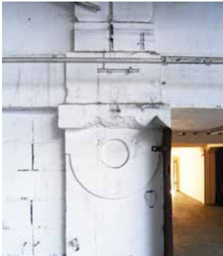
Ornament an einer Stütze (Foto: Barthel & Maus, Jörg Rehm)
