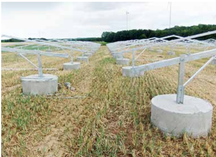
Uffenheim-Wallmersbach, Pulte auf Betonständern (Foto: BLfD, Martin Nadler)
