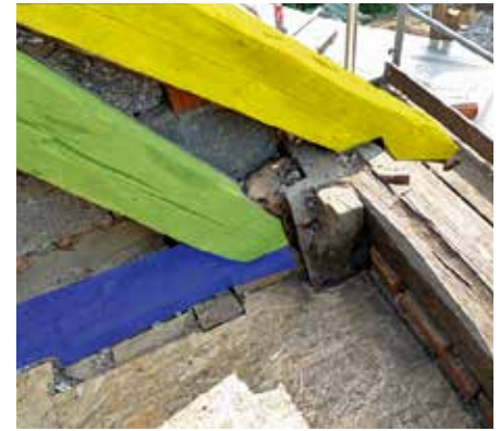
Dachfußpunkte im Vergleich: Bamberg, Mittelstraße 72 (links), 1467 (d) und Kaimsgasse 25 (rechts), 1455 (d). Blau: Zerrbalken, Grün: Sparren, Gelb: Aufschiebling (Foto links: Universität Bamberg, Modell des Dachwerks Mittelstraße 72, rechts: Ralf Jost, Bearbeitung: Autoren)
