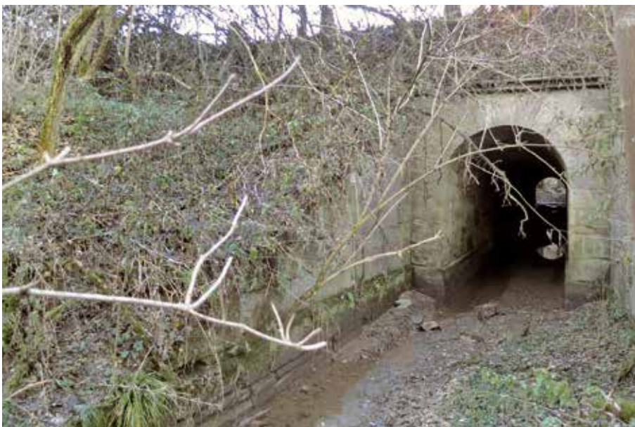
Schleuse 94, Kanaldurchlass ca. 800 m südlich der Schleusenammer, Ansicht von Westen (Foto: BLfD, Robert Pick)
