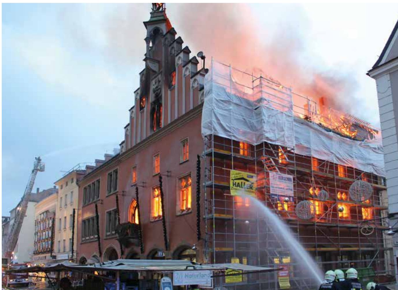
Straubing, Rathaus am 25. November 2016, gegen 17 Uhr bricht das verherende Feuer aus (Foto: Freiwillige Feuerwehr, Stadt Straubing)
