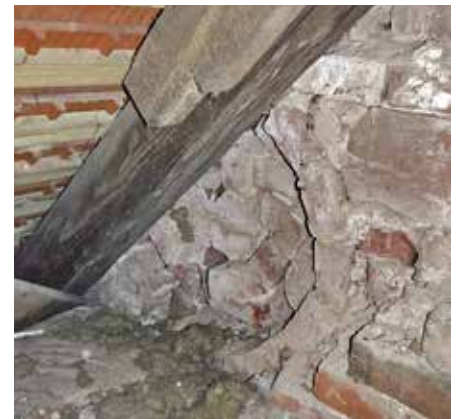
Giebel des Mittelrisalites, östlicher Basisbereich, mit erhaltener, gemauerter Volute
