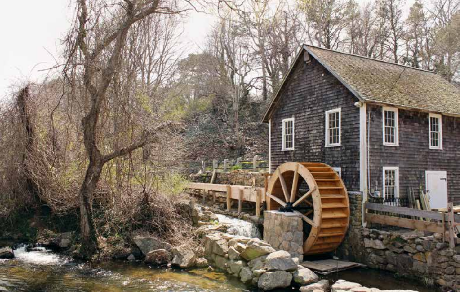
Brewster Gristmill mit neuem Mühlrad und Wasserzufuhr (Foto: C. Sebastian Sommer, 2011)
