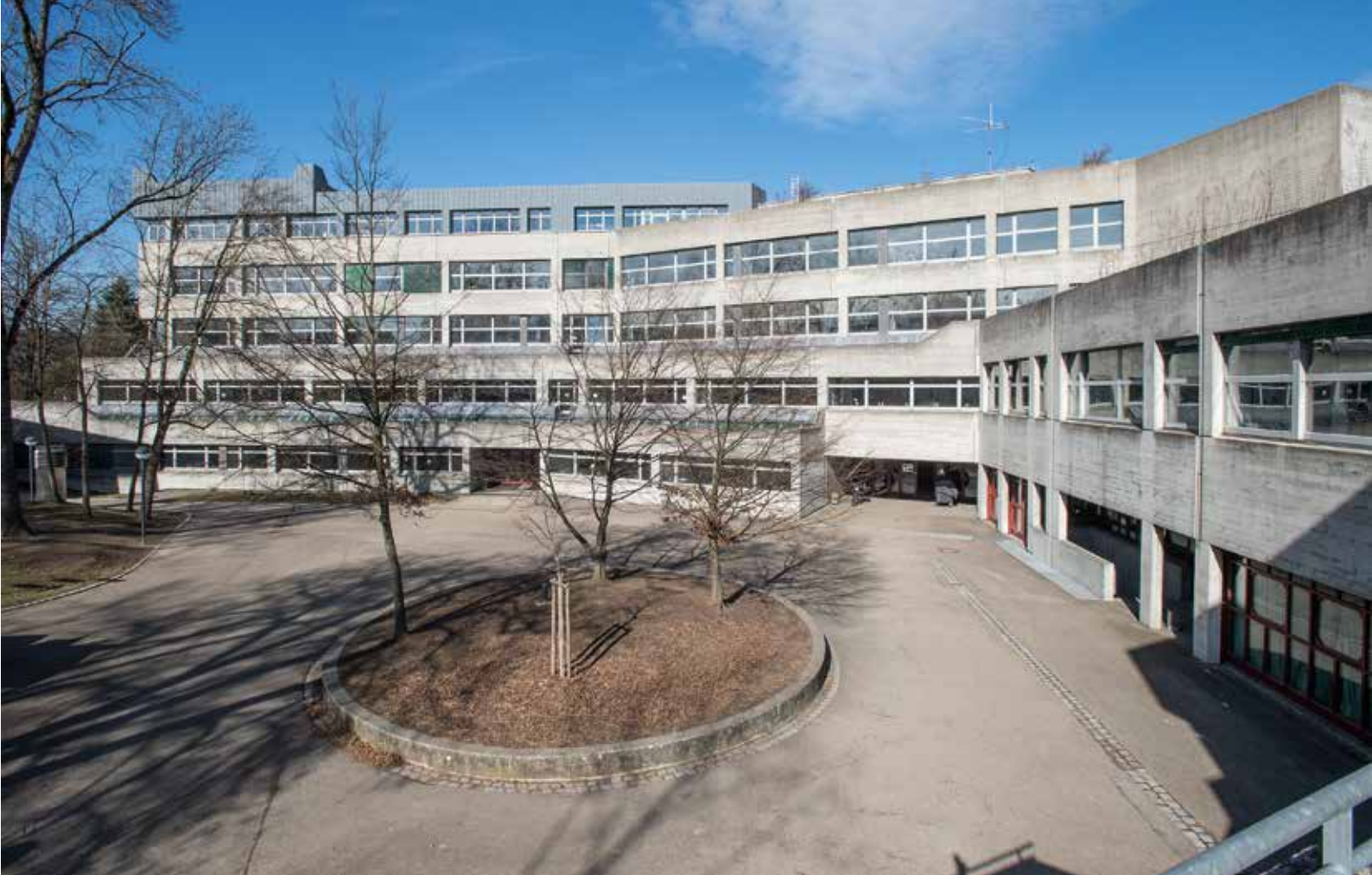
Ingolstadt, Katharinen-Gymnasium. Südansicht (Foto: BLfD, Michael Forstner)
