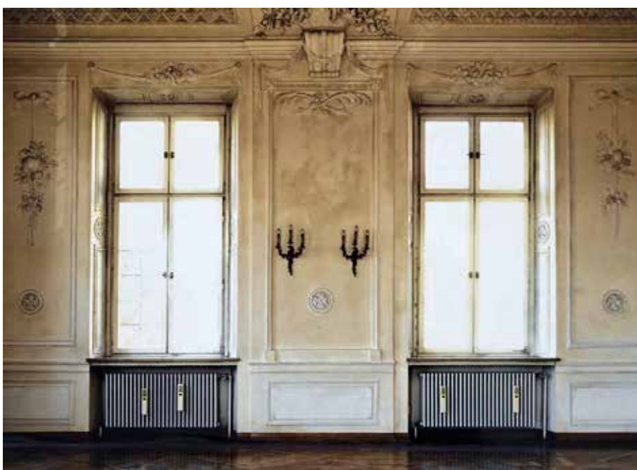
Zustand der Wände und Stukkaturen vor der Maßnahme (Foto: Obel Architekten, Donauwörth)
