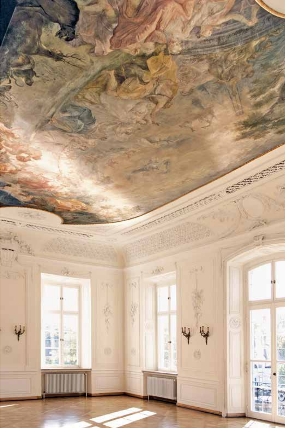
Blick in den Raum nach der Restaurierung (Foto: Obel Architekten, Donauwörth)
