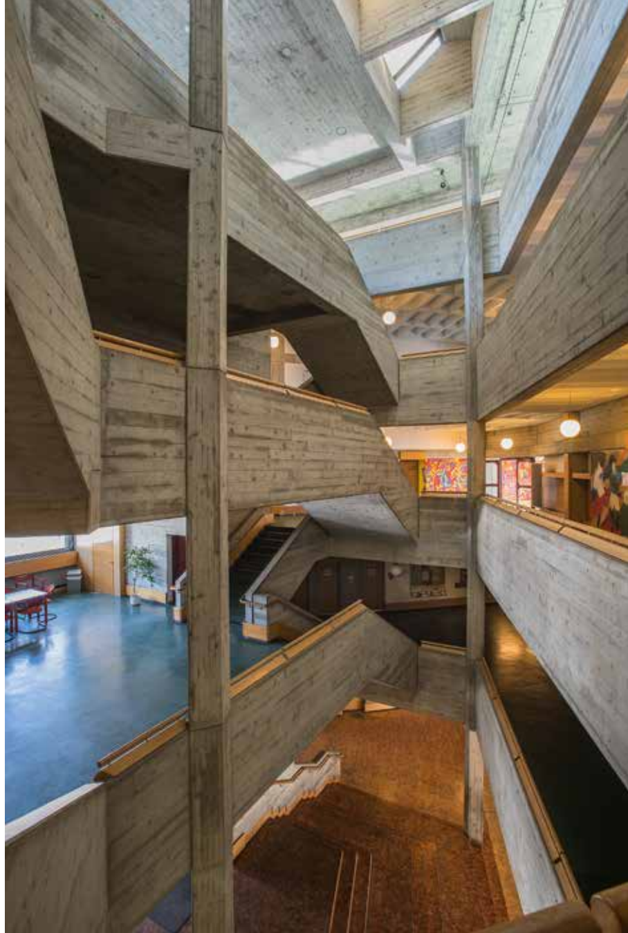
Ingolstadt, Katharinen-Gymnasium. Treppenfluchten (Foto: BLfD, Michael Forstner)
