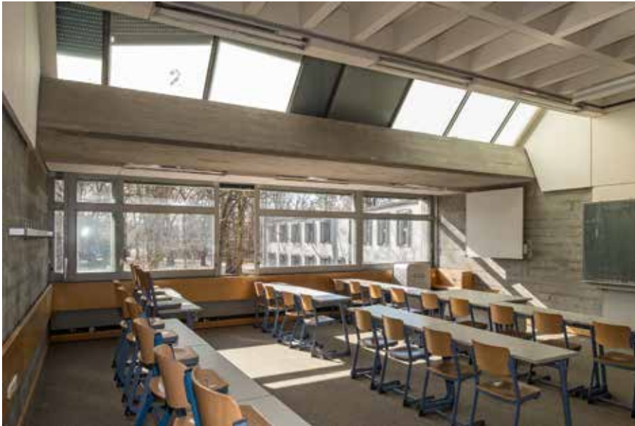
Blick in ein Klassenzimmer mit den erhaltenswerten Schiebefenstern (Foto: BLfD, Michael Forstner)
