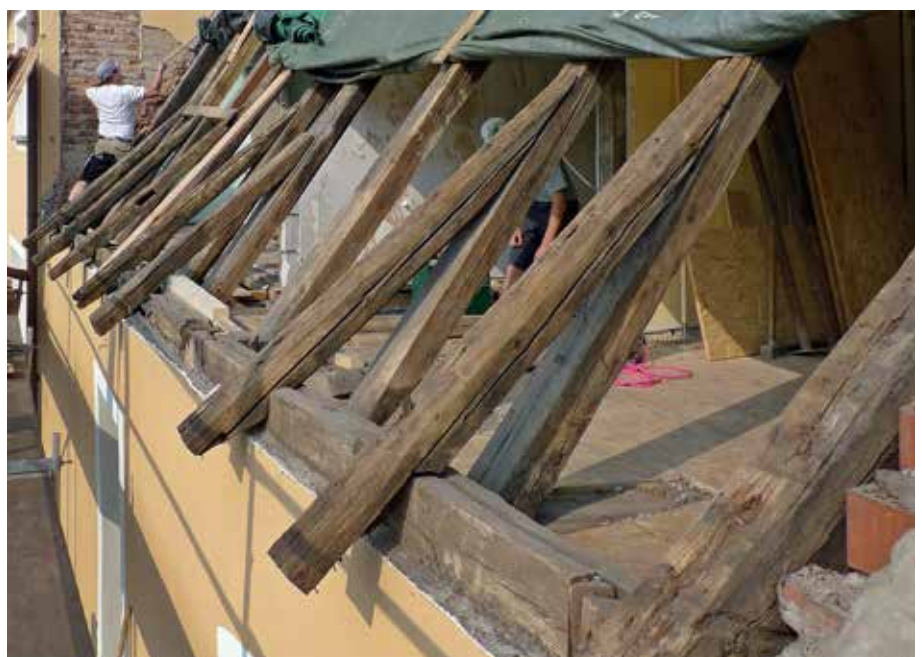
Bamberg, Kaimsgasse 25. Südliche Traufe während der Instandsetzung (Foto: Ralf Jost)
