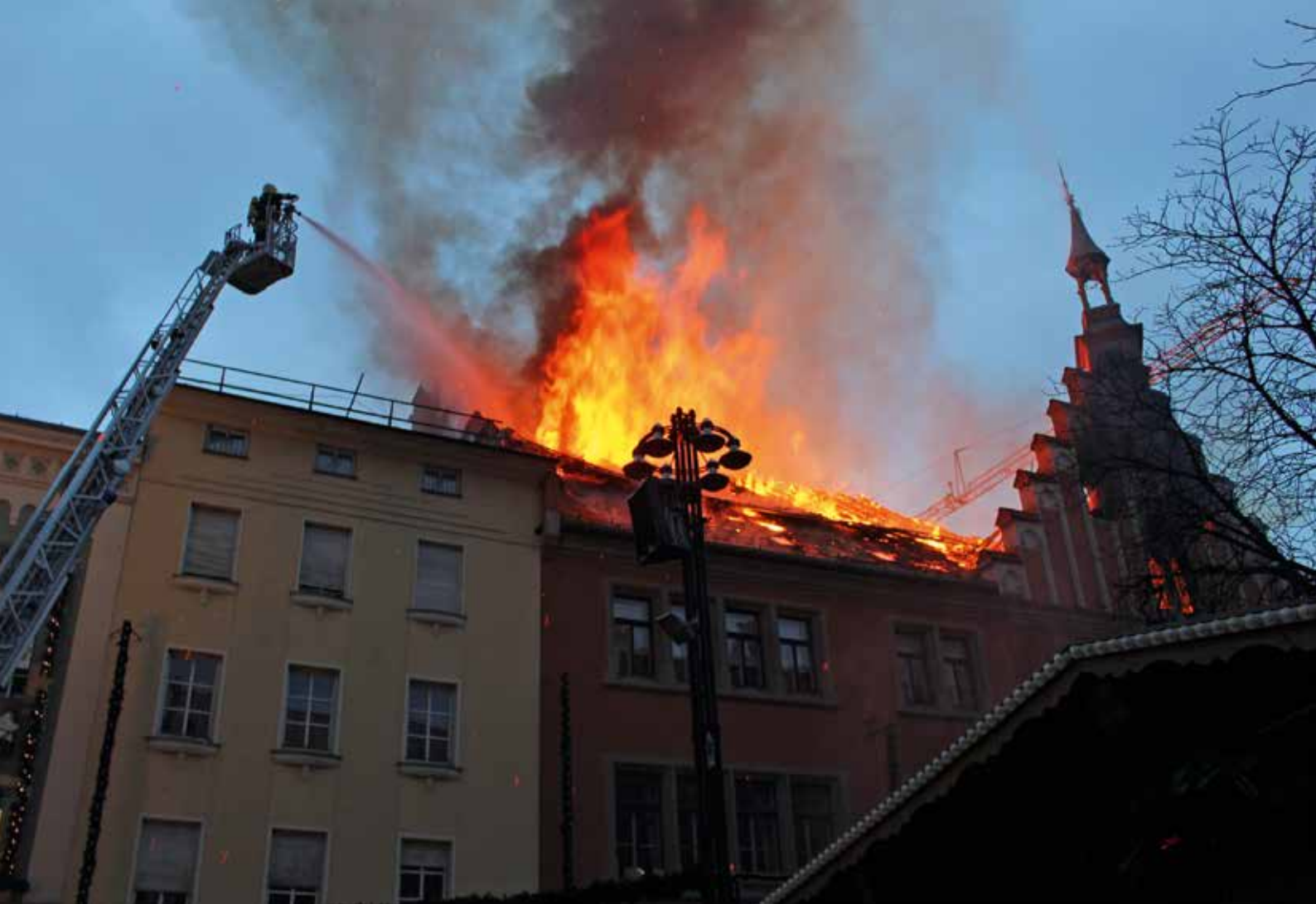
Straubing, Rathaus, die Löscharbeiten der Freiwilligen Feuerwehr der Stadt Straubing (Foto: Freiwillige Feuerwehr, Stadt Straubing)
