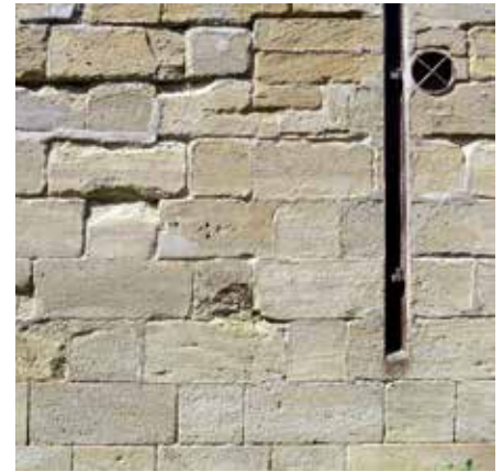
Schleuse 94, Befestigungskreuz und U-Eisen (Foto: BLfD, Robert Pick)
