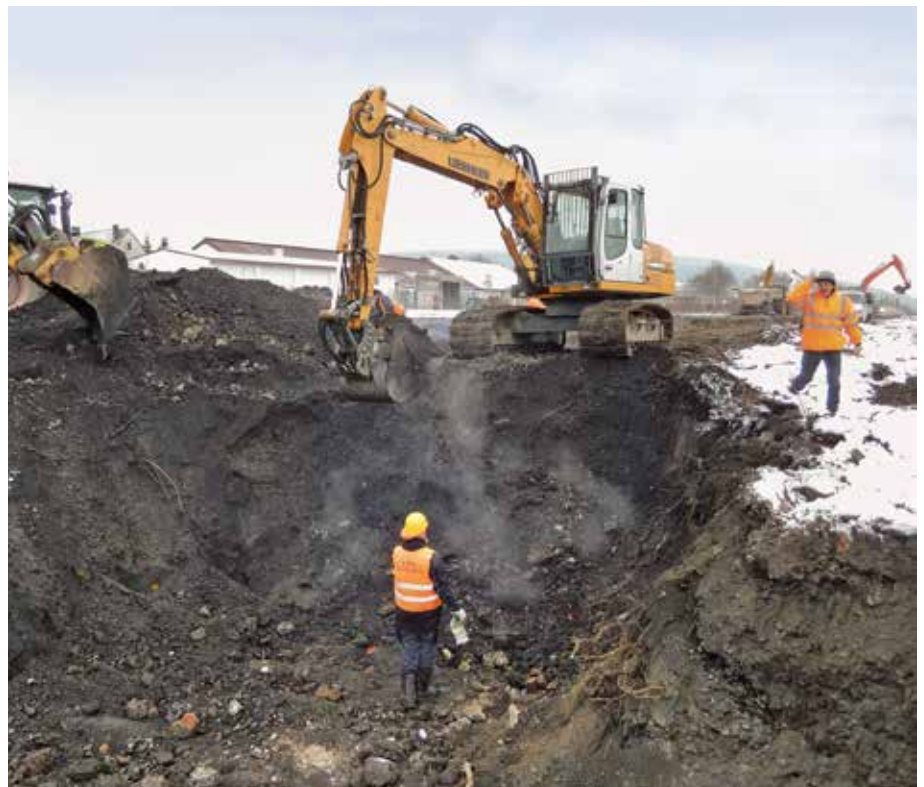
Zapfendorf, Arbeitsfoto bei der Freilegung des südlichen Kraterabschnittes. Der anstehende Boden wurde in diesem Bild noch nicht erreicht (Foto: ArchDienst GmbH & Co. KG, Matthias Tschuch)
