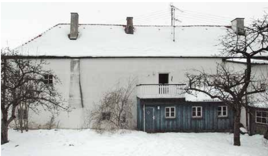
Ansicht der Nordfassade des Bischofshauses, vom ehem. Klostergarten der Birgittinnen aus (Foto: Christian Kayser)
