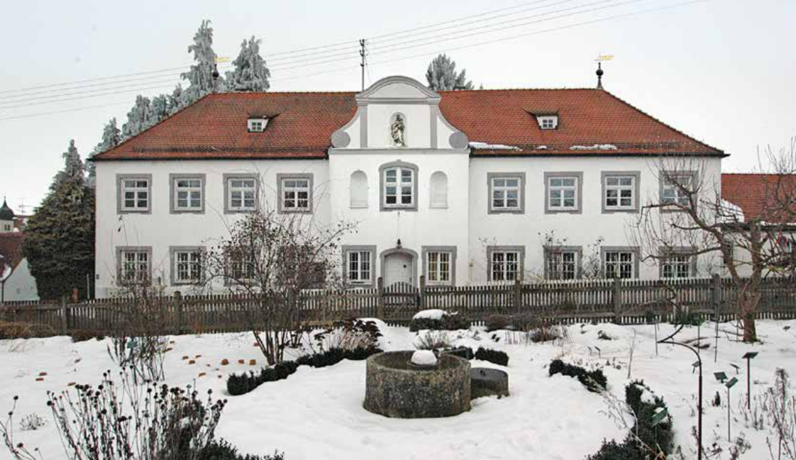
Rekonstruierte bauzeitliche Gestaltung der Südfassade (Fotomontage: Christian Kayser)
